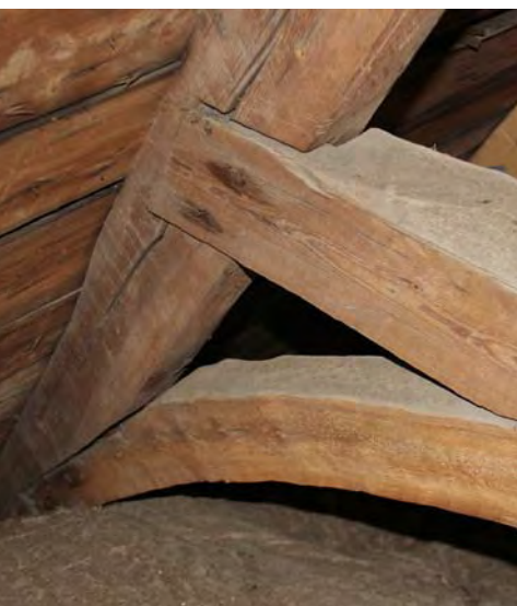
Del av takstolen i Sala sockenkyrkas vapenhus: högben, hanbjälke och valvbåge. Foto: Lisa Skanser (KM).
