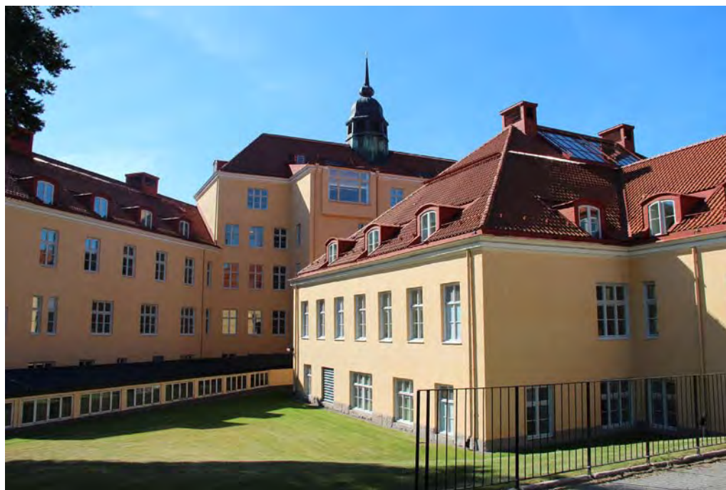
Lasarettet idag, baksidan med bakre flyglar. Foto: Helén Sjökvist (KM).
