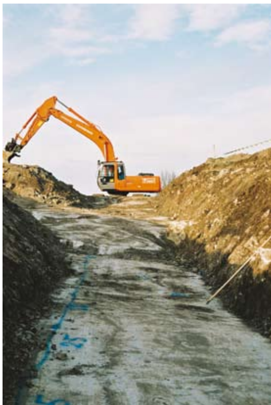
Figur 35. Bilden illustrerar den nivåskillnad som fanns i området. Grävmaskinen på bilden är placerad på krönet av höjdryggen, på platsen för slutundersökningsområdet. Fotograferat från den nedre delen av höjden, i kanten mot åkern öster om Floras kulle. Foto: Anna-Lena Hallgren, VLM.
