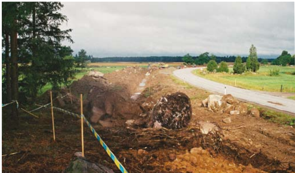
Figur 2. Arbetet med att lägga ner fjärrvärmeledningen påbörjades i stort sett samtidigt som de arkeologiska förundersökningarna drog i gång. Vid den arkeologiska undersökningen av RAÄ 41 i Fjällsta, Svedvi socken, blev vi nästan uppbunna av Skanska som grävde ner fjärrvärmeledningen på den här etappen. Här har undersökningen på gravfältet just avslutats. Fotograferat från krönet av gravfältet, mot väster. Foto: Anna-Lena Hallgren, VLM.
