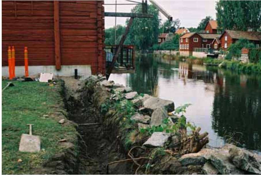
Figur 4: Schakt I längs Arbogaån, dokumenterat som sektion I. Fotograferat av Joakim Kjellberg 2005.
