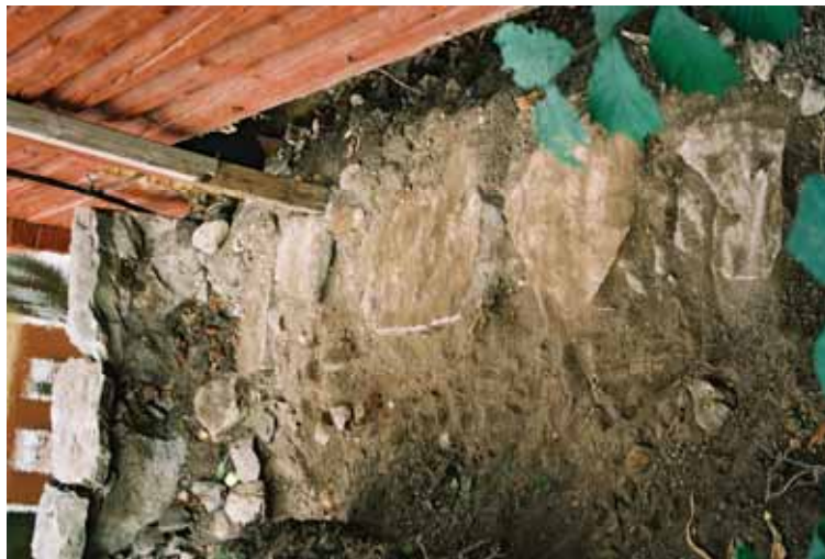
Figur 9. Syllstenskonstruktionen invid den stående byggnaden. Fotograferat av Joakim Kjellberg 2005.
