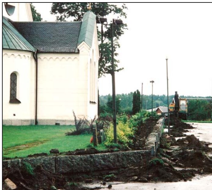
Figur 10. Det östra murpartiet vid schaktningsarbetena (foto U. Alström).
