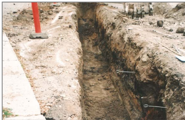
Figur 2. Schaktet för dagvattenbrunnen i norra delen av undersökningsområdet. (foto Ulf Alström).
