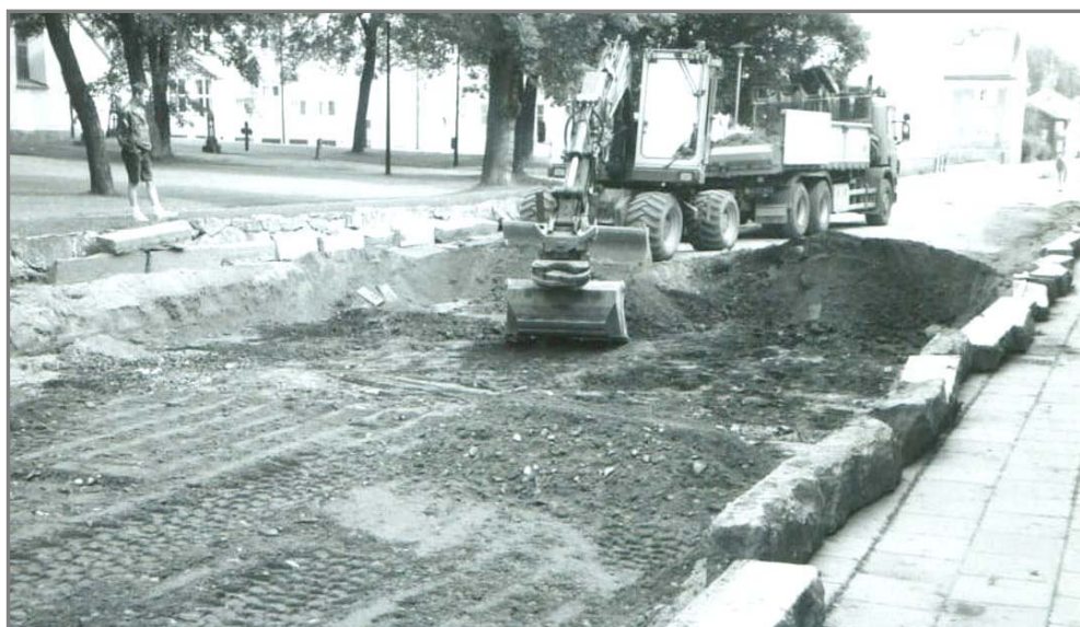
Figur 1. Aguèligatan från söder. Bilden visar schaktningarna i hela gatans bredd. Nederst i bild ligger nypålagt fyllnadsmaterial. Vid skopan är djupet under marknivån cirka 0,7 meter. I det mörkare lagret till höger om skopan finns rester efter huslängorna (foto Ulf Alström).
