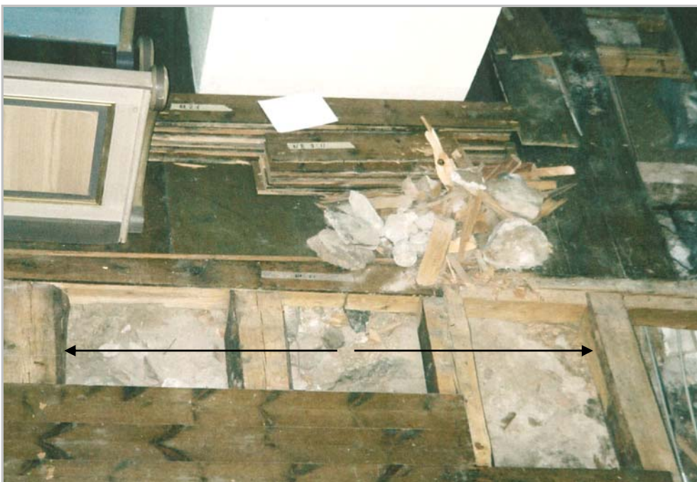
Figur 20. Den två meter breda 1400-talsmuren mellan de två södra kolonnerna. Murens begränsningar anges med pilar (foto Ulf Alström).
