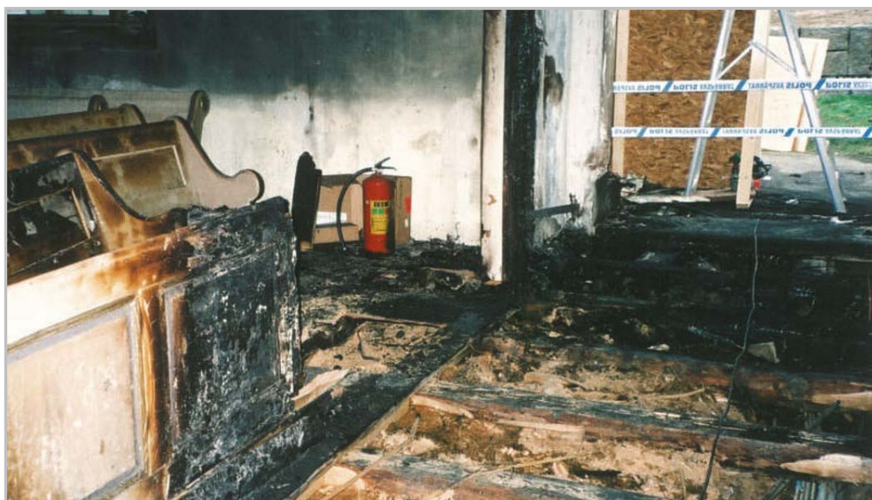
Figur 3. Brandskador vid norra ingången (foto Ulf Alström).
