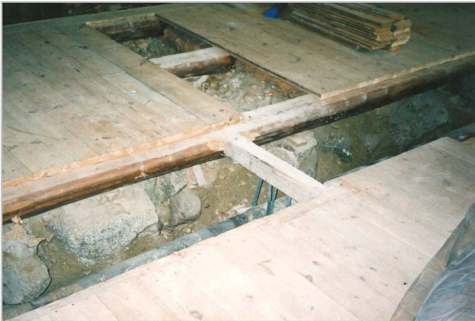
Figur 19. Delar av kyrkans gamla östmur. Hitom muren löper de gamla ledningarna från 1937 (foto Ulf Alström)
