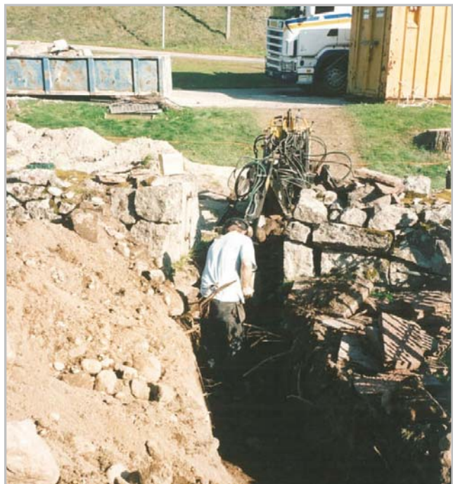
Figur 10. Vid kyrkogårdens östra ingång grävdes det större ledningsschaktet vilket ledde in till korets södra utbyggnad som byggdes 1791-92 (foto Ulf Alström).
