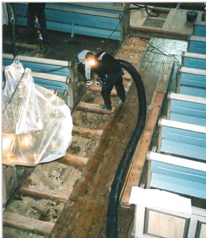
Figur 13. Arbete med spånsugning i kyrkans mittgång. Slangen leder ut till sugbilen (foto Ulf Alström).
