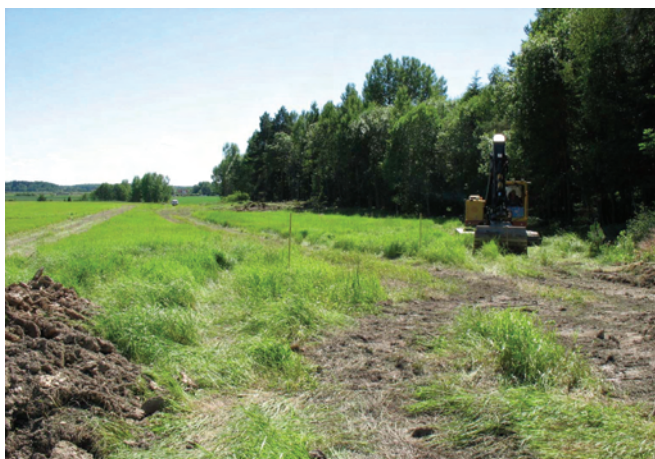
Figur 20. Vy över dikessträckningens södra del. Foto fr N J Åhlström.
