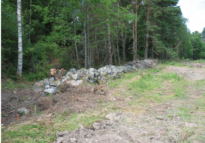
Figur 23. Stenmuren A1336 från SV. Foto A Lihammer.
