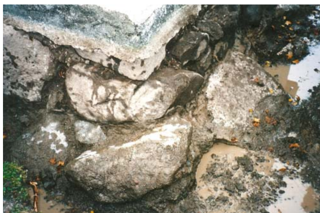
Figur 15. NÖ hörnet av sakristian med de extra grundstenarna. En sten grävdes här bort (foto Ulf Alström).
