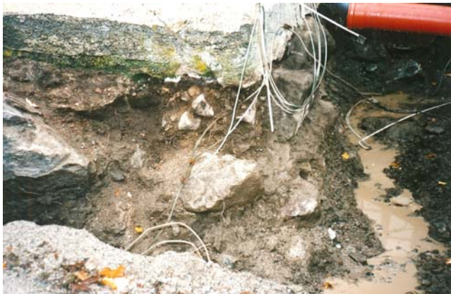
Figur 18. NÖ hörnet av kyrkan med bortgrävda grundstenar (foto Ulf Alström).
