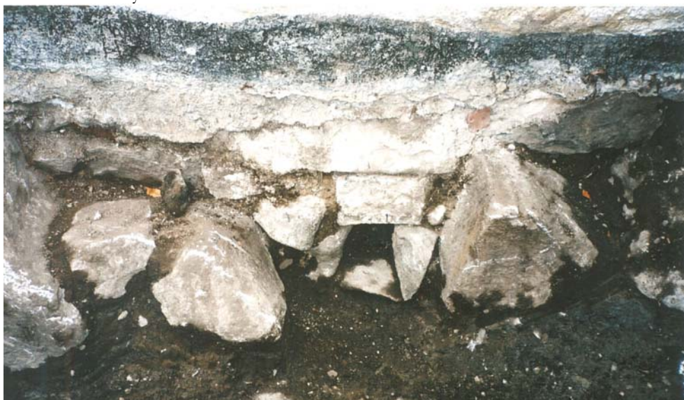
Figur 8. Mynningen av en ventilkanal i sten i sakristians västra vägg (foto Ulf Alström).
