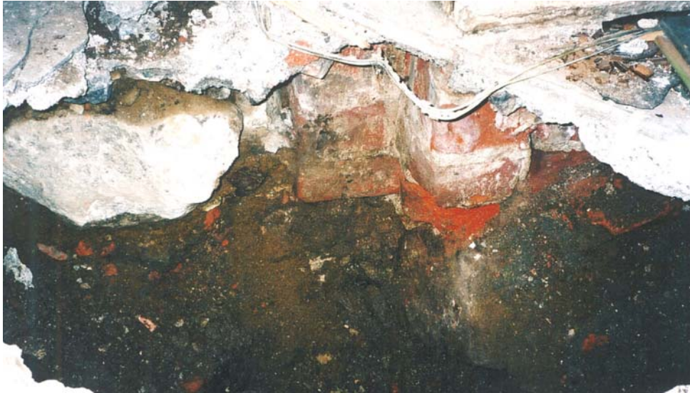
Figur 3. Undersökningsgrop, schakt A, från 2005 med pelarfundamentet (foto Ulf Alström).
