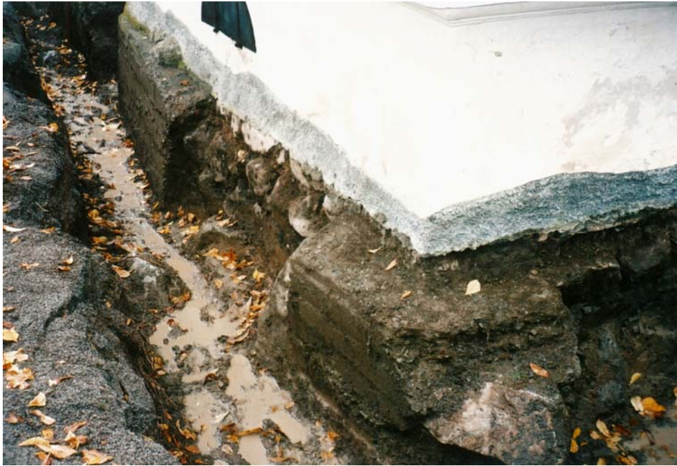
Figur 12. Gravkorets grund med det förstärkta sydöstra hörnet närmast i bild (foto Ulf Alström).
