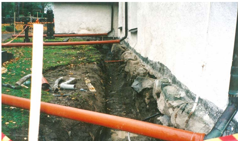
Figur 6. Norra väggen efter friläggande. Grundstenarna blåstes rena med tryckluft (foto Ulf Alström).
