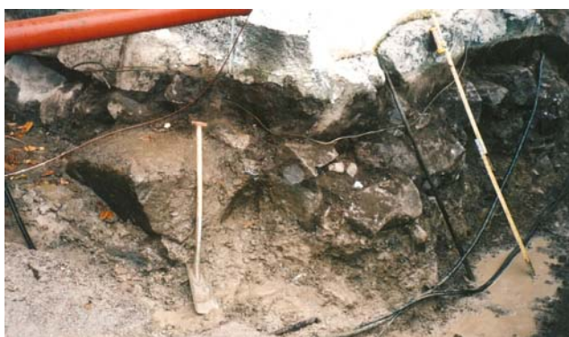
Figur 16. NV hörnet av kyrkan där minst 1 hörnsten är borttagen (foto Ulf Alström).
