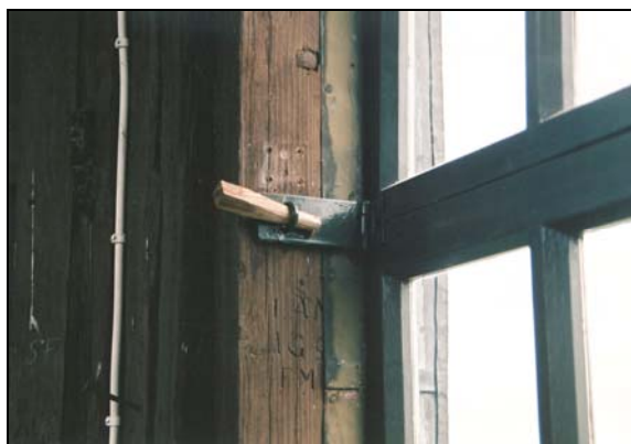
Figur 12, överst t.v. Nyttillverkade bågar. Bågarna tillverkades i två delar lika befintliga. De ytterligare äldre bågarna som förvaras i tornet var hela. Digitalfoto KM.
