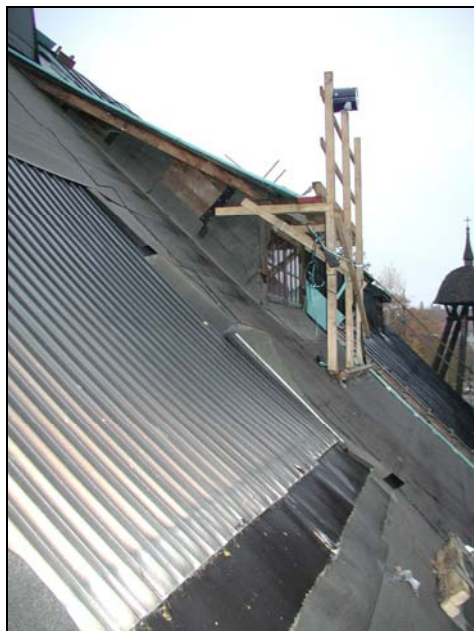
Figur 8, överst t.v. I anslutningen mot putsen behålls äldre plåt på burspråket och ny falsades i. Foto KM.
