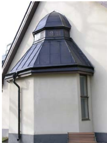
Figur 20, överst t.v. Arbete med att täcka om takryttaren. Plåten är satt med klämmor. Foto: KM.
