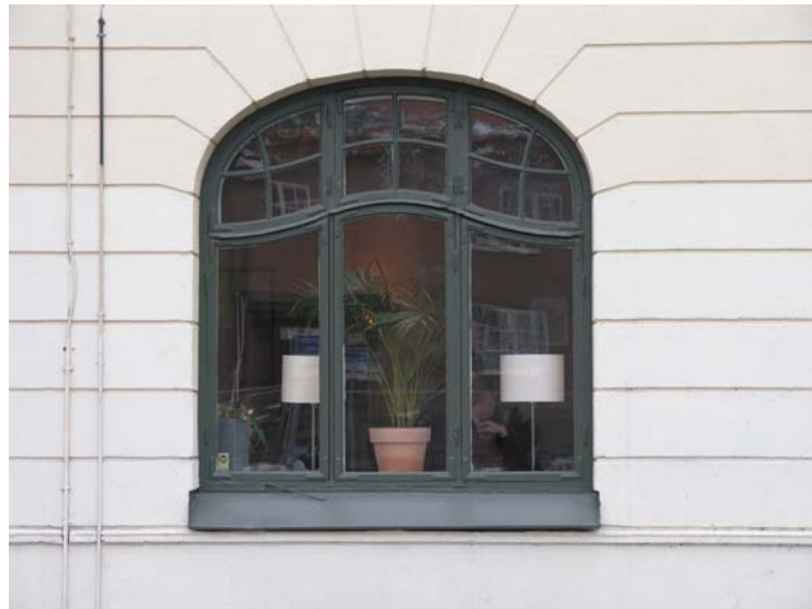
Figur 12: Fönster i bottenvåningen mot Karlsgatan. Typisk jugendform med korgbåge, organiska former och småspröjsade övre rutor.
