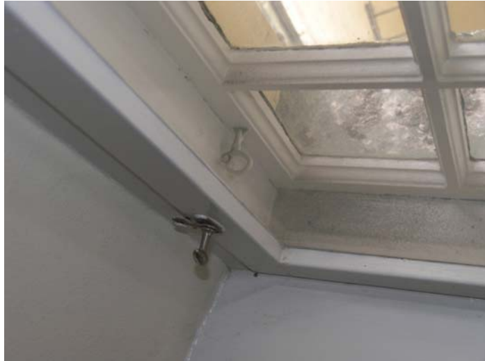
Figur 22: Trapphusens fönster är försedda med lösa innerbågar med äggvred.
