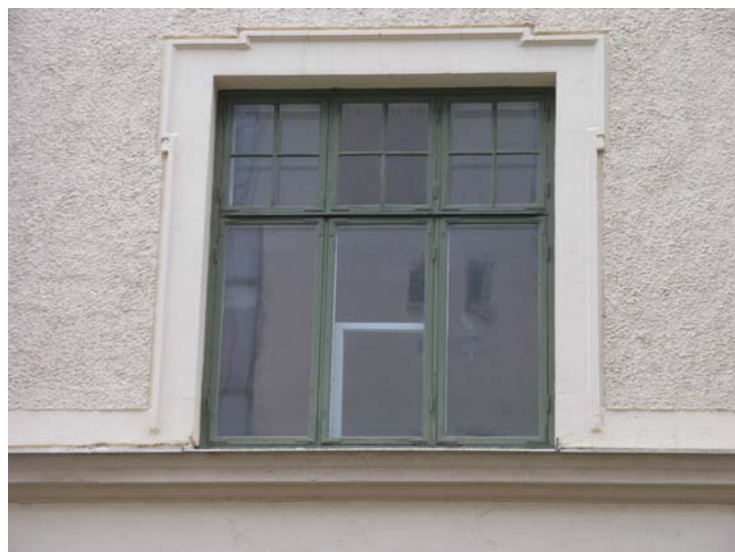
Figur 13: Fönster till andra våningsplanet med korspost, sex luster och en typisk jugendform. Omfattningen är slätputsad med en profilerad ytterkant.
