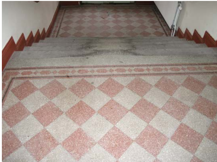
Figur 20: Golvplattor i engelskt rött och grått i entrén och trapphusets vilplan.
