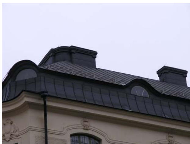
Figur 5: Takfallet mot Stora gatan. Tvärfalsarna är ej förskjutna. Takkuporna är utanpåliggande och försedda med med lunettfönster. Skorstenarnas inkläddning är profilerad. Trattarna till takavattningen tycks även de vara i originalutförande.
