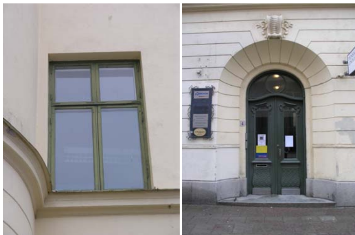
Figur 14: På baksidans fasader finns en enklare fönstertyp med korspost och utan småspröjsad övre del.
