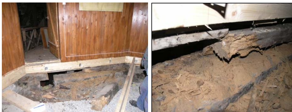
Figur 9 t.v. Under regeln för det moderna golvet syns den bjälke som byttes. Hela längden från strax förbi vänster dörrkarm fram till hörnet i bildens högra del byttes. En del av bjälken är här redan borttagen. Foto KM.
