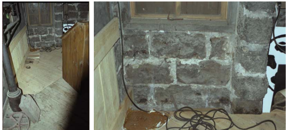
Figur 3 t.v. Tidigare utbytt golv 2004 i hörnet av rum 1. Hussvampskroppen ansas inne i hörnet hösten 2005. Foto: Västmanlands läns museum B104131:5.
