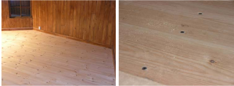
Figur 15 t.v. Nyinlagt golv i mineralsamlingsrummet. Foto KM.
