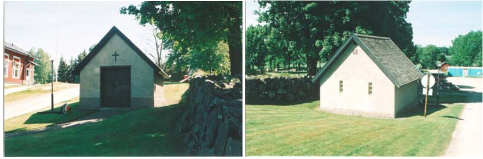
Figur 52. Bisättningshuset från väster före renovering. Foto KM.
