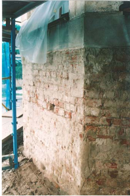
Figur 22. Gravkorets nedre del knackades helt ren från befintlig puts. Mur med blockförband. Foto KM.
