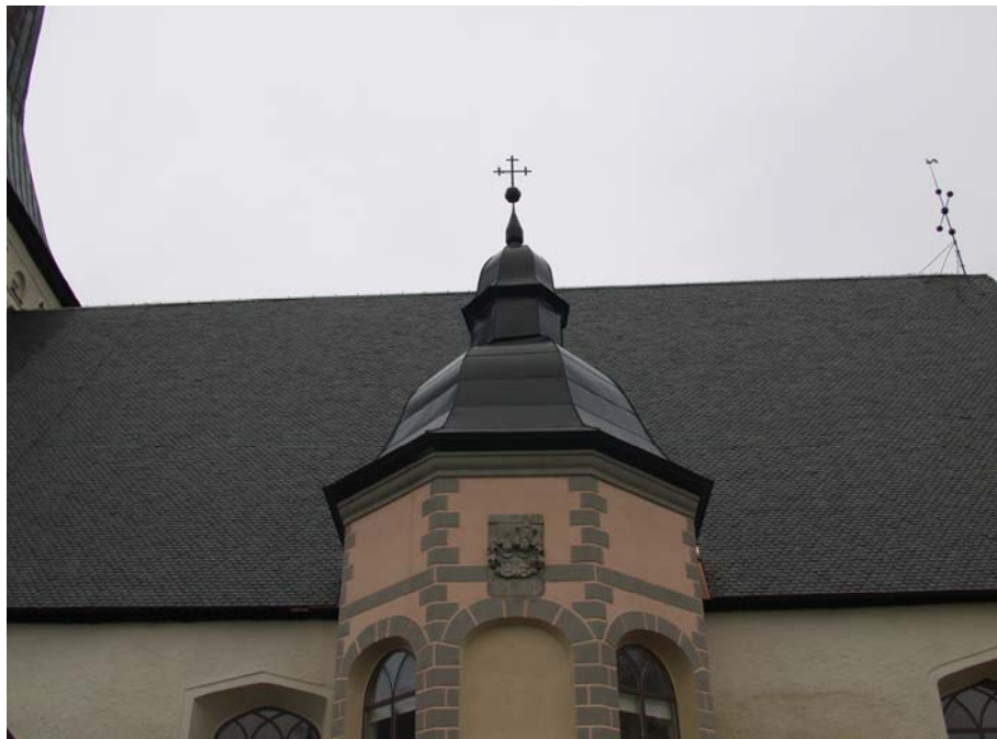
Figur 40. Färdig omtäckning av taket på gravkoret. Foto KM.
