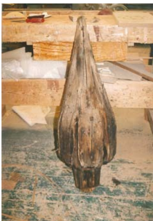
Figur 34. Stommen på gravkorets tak. Foto KM. Figur 35. Den avsågade träkärnan till spiran, intagen på verkstad. Kärnan var tillverkad i ett stycke och formad med yxa. Foto KM.
