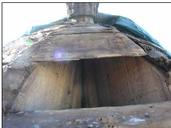
Figur 34. Stommen på gravkorets tak. Foto KM. Figur 35. Den avsågade träkärnan till spiran, intagen på verkstad. Kärnan var tillverkad i ett stycke och formad med yxa. Foto KM.
