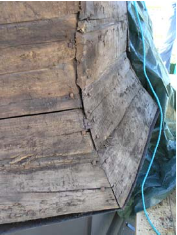
Figur 32. Brändundertak med rötskador på gravkorets övre tak. Panelen byttes helt. Foto KM. Figur 33. Den gamla panelen, väl anpassad efter takets form. Foto KM.
