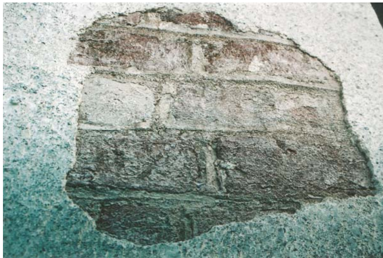
Figur 60. Den fotograferade tegehytans nedre del ligger 7,83 m över nedersta bomlag. Tegelstorlek 29x~8,5-9,5x? cm. Fogarna har antydning till åsar. Foto KM.
