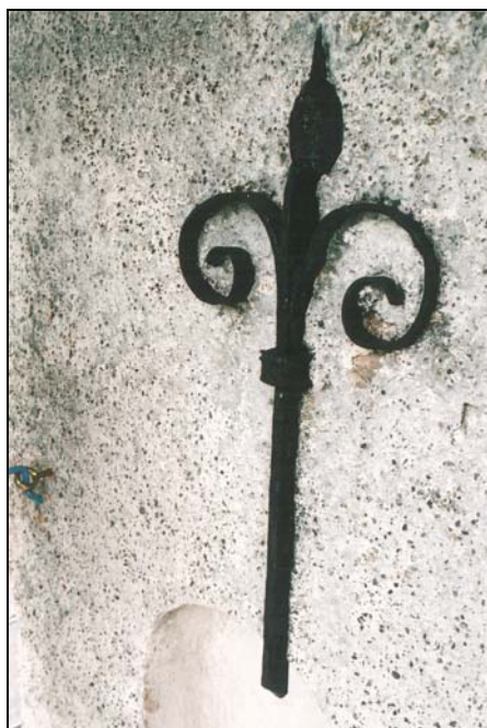
Figur 26. Ankarjärn av 1600-tals typ på tornets södra fasad, före målning. Foto KM.
