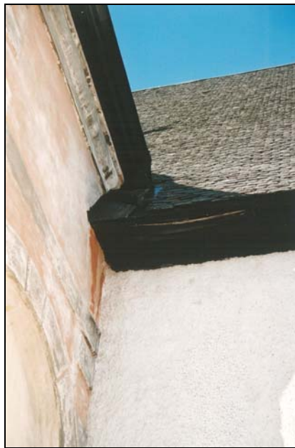
Figur 18. Skador vid takfot i anslutning mellan gravkor och långbus. Foto KM.
