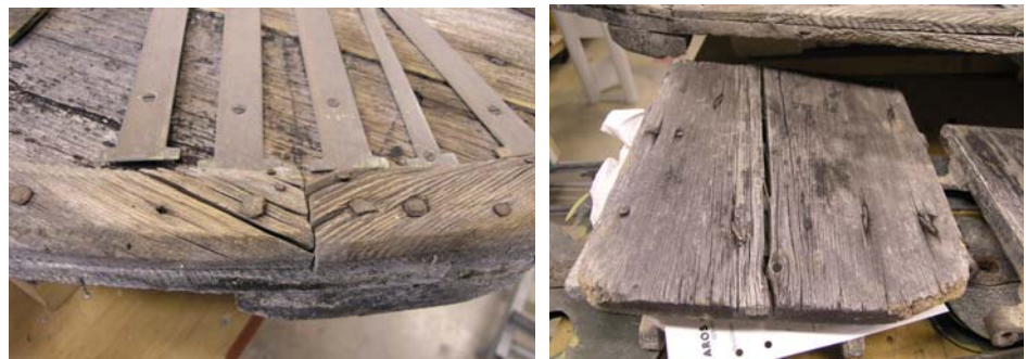
Figur 43. Ram omkring uret fäst med smidd spik. Siffror fästade med spårskruv. Foto KM.
