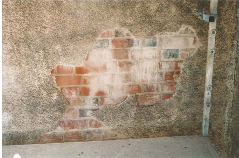
Figur 59. Stortegel över naturstensmuren, tornets sydsida 31,5x10,5x15 cm. Från ställningens understa bomlag är det 7,35 m upp till den fotograferade tegehytans övre del. Foto KM.
