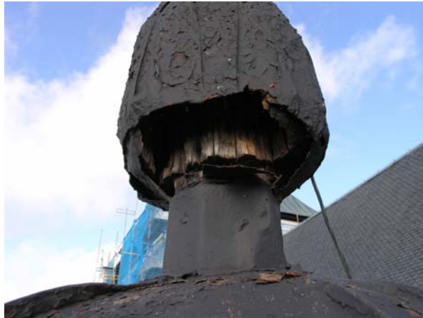
Figur 30. Kraftigt rostangripen plåt samt rötangripen trästomme i spiran på gravkoret. Foto KM. Figur 31. Rosthål i plåt på övre del av tak på gravkoret. Foto KM.
