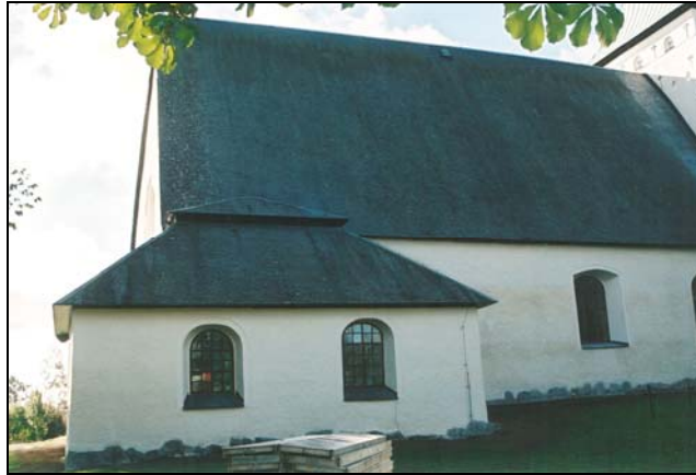
Figur 16. Norra fasaden efter renovering. Foto KM.
