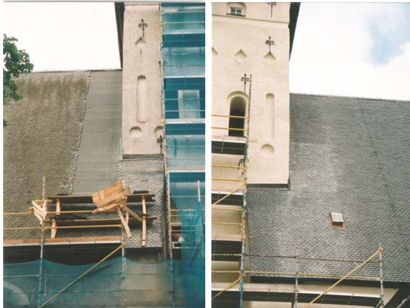
Figur 49. Nedplockning av skiffer, norra sidan. Foto KM.
