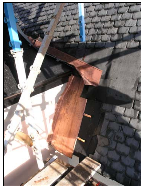
Figur 18. Skador vid takfot i anslutning mellan gravkor och långbus. Foto KM.
