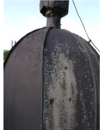
Figur 30. Kraftigt rostangripen plåt samt rötangripen trästomme i spiran på gravkoret. Foto KM. Figur 31. Rosthål i plåt på övre del av tak på gravkoret. Foto KM.
