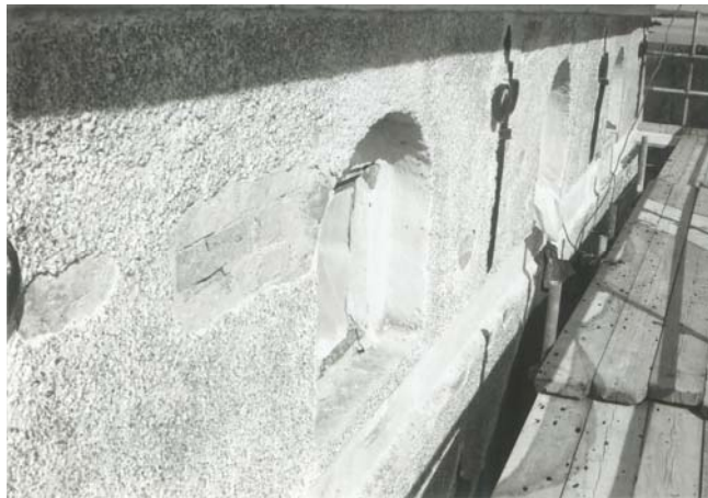
Figur 12. Putskskador på tornets översta del mot öster före renovering. Foto KM.
