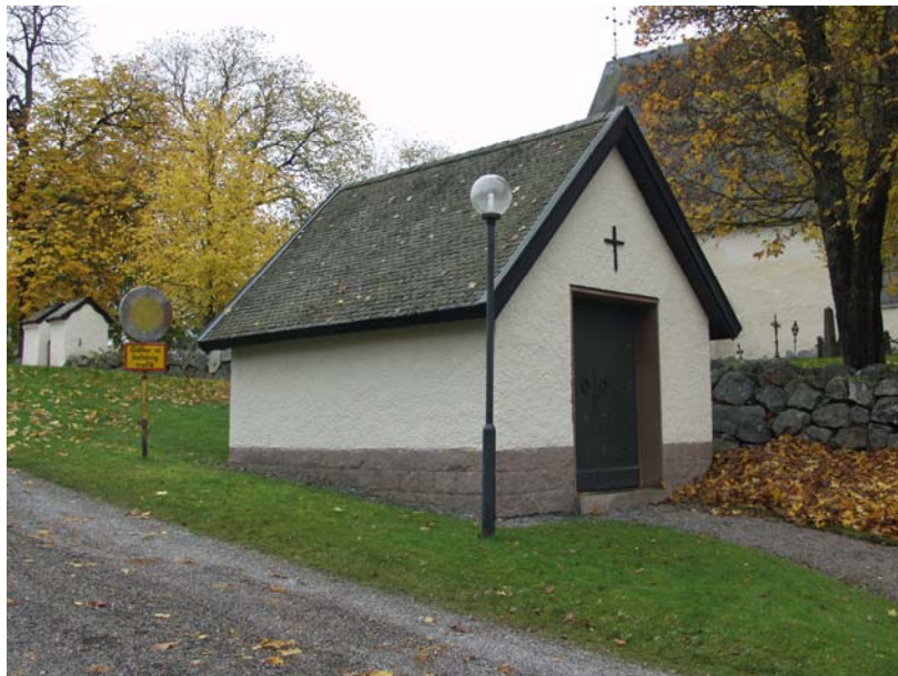
Figur 51. Bisättningshuset efter renovering. Foto KM.
