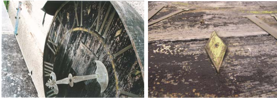
Figur 41. Tornuret på södra sidan före renovering. Foto KM.
