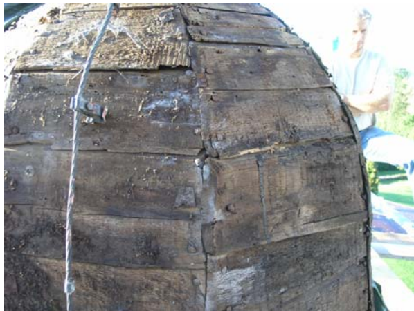
Figur 32. Brändundertak med rötskador på gravkorets övre tak. Panelen byttes helt. Foto KM. Figur 33. Den gamla panelen, väl anpassad efter takets form. Foto KM.
