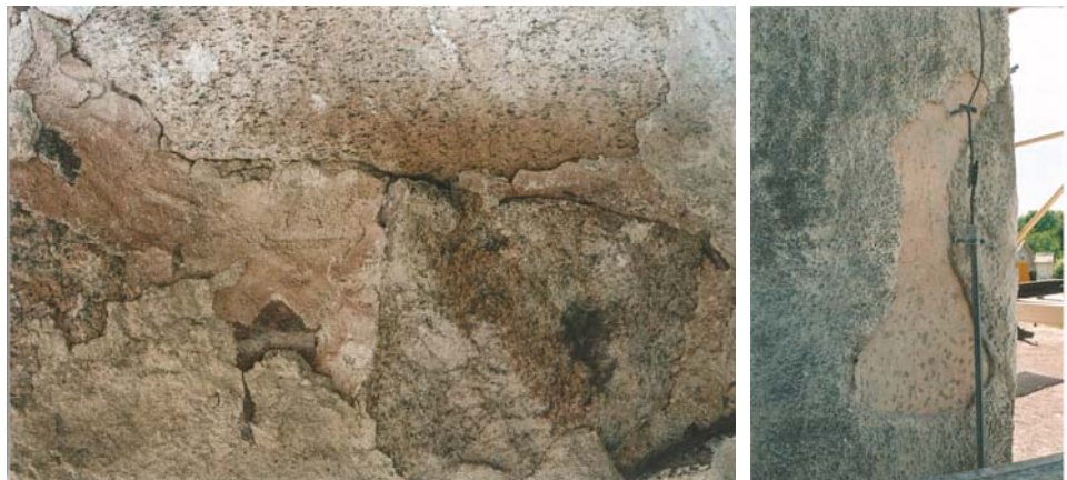
Figur 6. Spår av rosafärgat fogbruk i naturstensmuren på tornets södra sida. Foto KM.
