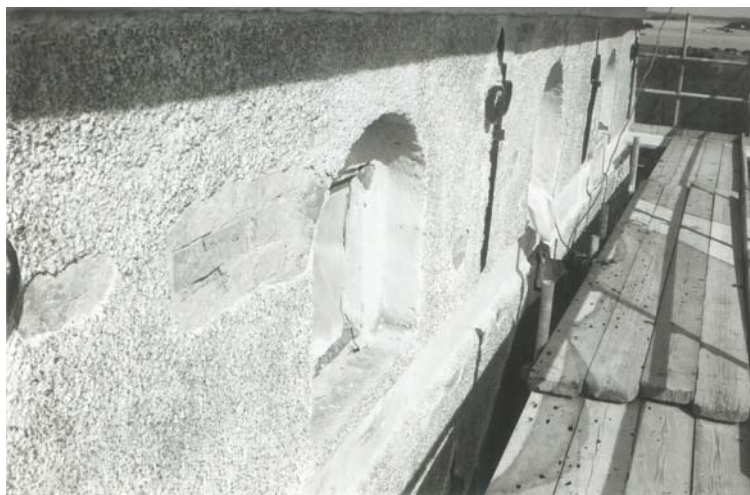
Figur 64. Blindingar översta bomlag östra sidan. Tegelstorlek 27x7x?cm. Foto KM.
