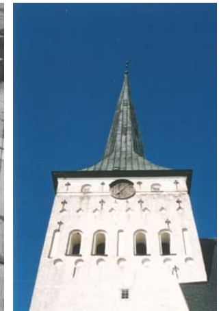
Figur 12. Putskskador på tornets översta del mot öster före renovering. Foto KM.
