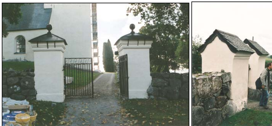
Figur 56. Nordvästra entrén efter renovering. Foto KM.
