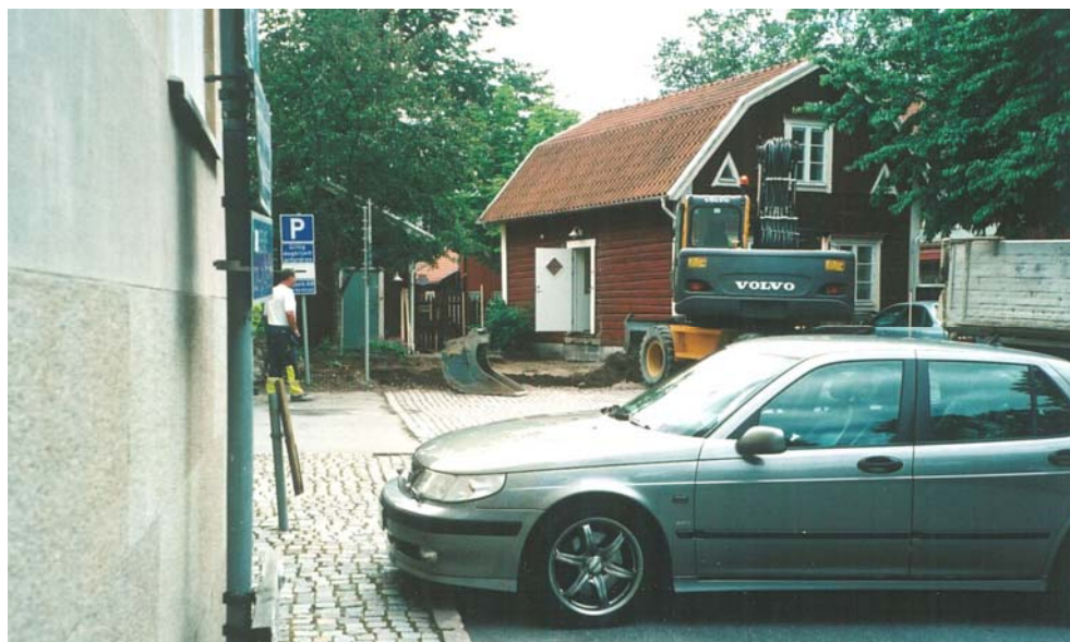
Figur 2. Kvarteret Jarl 5 från norr. Avbaningsarbetet pågår. (Foto Ulf Alström).
