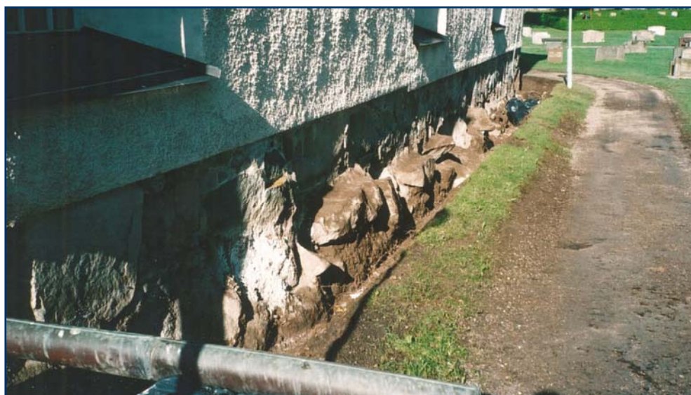
Figur 10. Västligaste delen av norra sidoskeppets grundmur. Vid den flata stenen i skuggan till vänster i bild upphör grundens oregelbundenhet. (Foto U. Alström).
