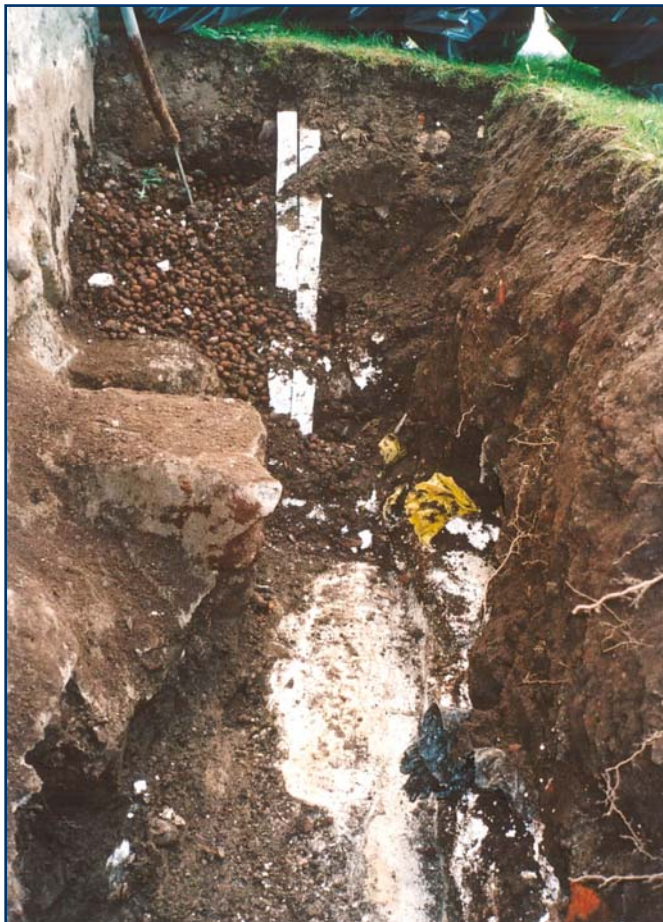
Figur 4. Exempel på den gamla fyllningen från 1985 som nu grävdes bort. (Foto U. Alström).
