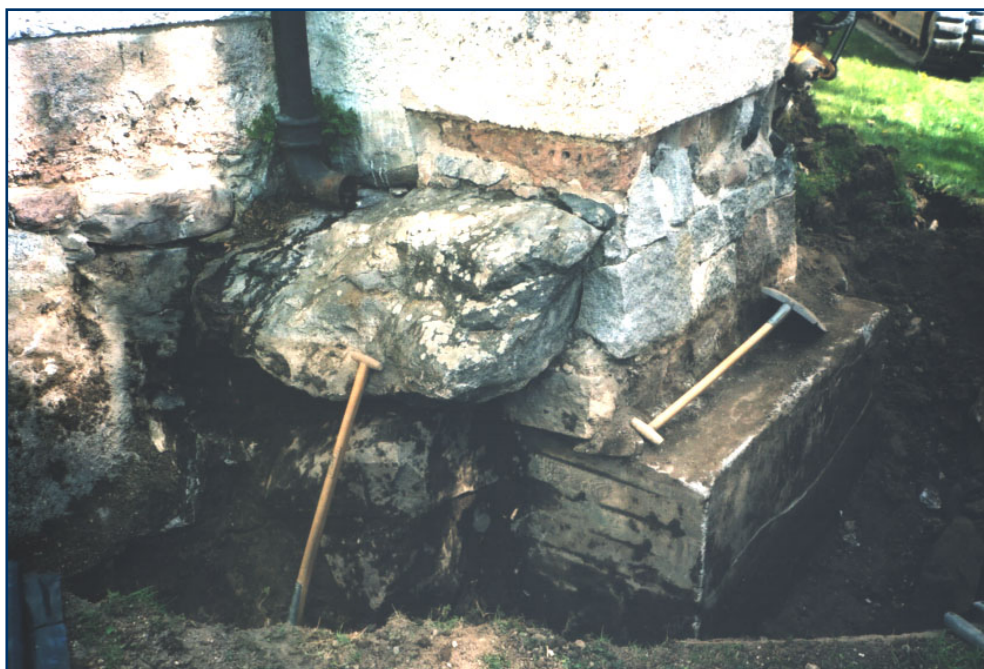
Figur 14. Betongförstärkningen under den sydöstra strävpelaren (foto U.f Alström).
