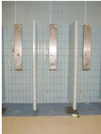
Figur 69. Duschar i damernas tvagningsrum. Det ursprungliga kaklet är bytt mot nytt, ljusblått i stående format.
