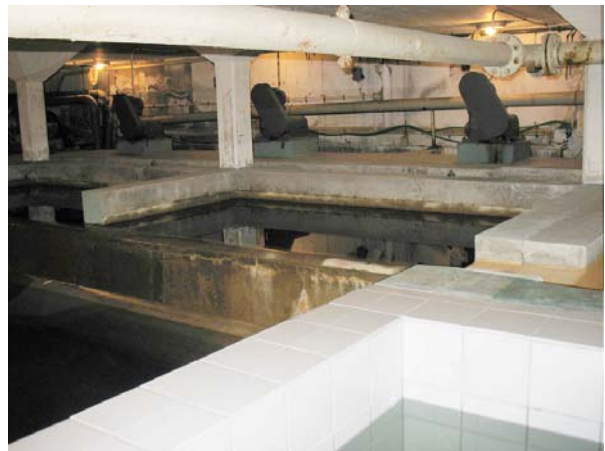
Figur 101. Utrymmet under den grunda delen av stora bassängen utnyttjas för maskinrummet. Längst bort i bilden syns slutningen där den djupare delen tar vid.
