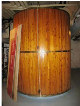
Figur 113. Äldre tryckluftsbaserad ventilation vilken idag används för romerska badet.
