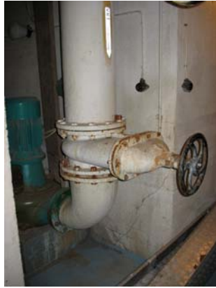
Figur 111. Pump till sanbbirkulationen i stora bassängen. Det finns generellt sett problem med att de gamla gjutjärnsrören börjar angripas av rost.
