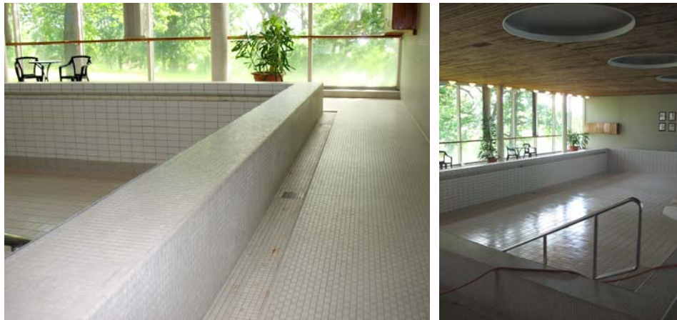
Figur 47. Upphöjd kant kring lilla bassängen. Hela golvet och bassängkanten är klädd med mosaik.
