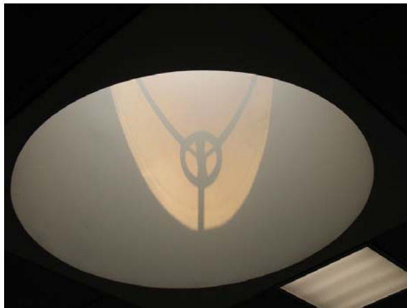
Figur 71. Ljusinsläpp över damernas tvagningsrum. Skugga från armatur.
