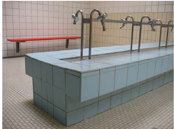
Figur 69. Duschar i damernas tvagningsrum. Det ursprungliga kaklet är bytt mot nytt, ljusblått i stående format.
