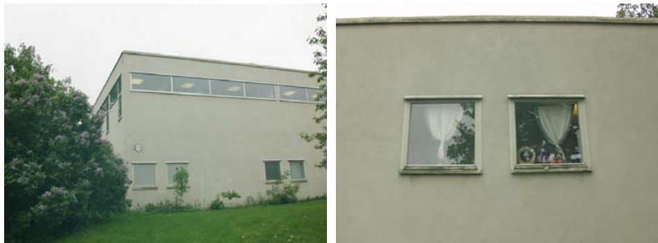
Figur 19. Norra fasadens östra del med ett långt smalt fönsterband högt placerat. Figur 20. Fönster med träbågar på norra fasadens västra del.
