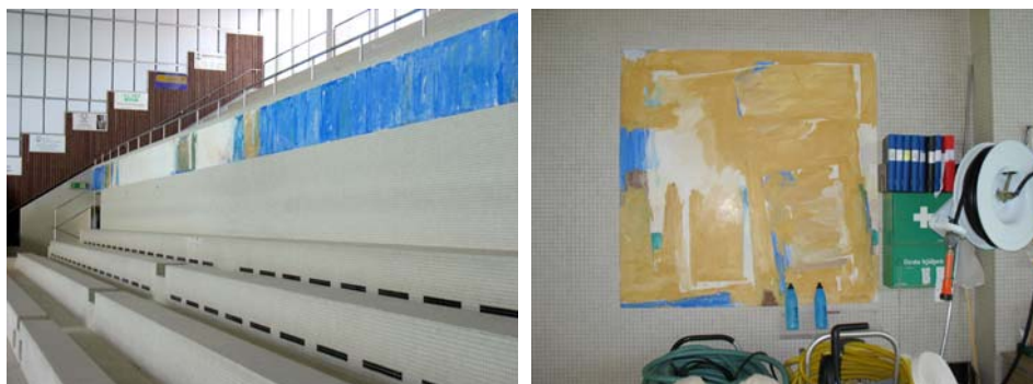
Figur 59. Enno Halleks stucco lustromålning utmed läktaren.
