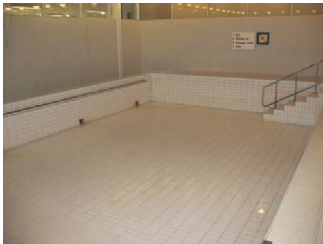
Figur 53. Den vänstra väggen var före utbyggnaden en yttervägg som vette mot solterrassen.
