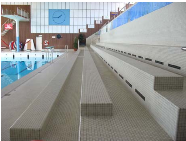
Figur 43. Läktaren med uppböjda sittplatser är helt täckt med mosaik. I framkant av sittplatserna finns ventilationsöppningar.
