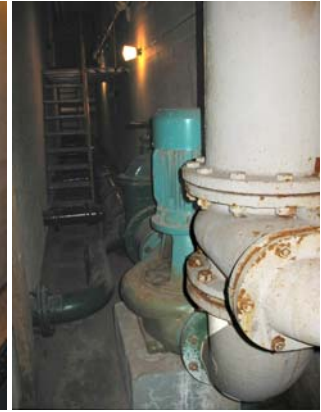
Figur 111. Pump till sanbbirkulationen i stora bassängen. Det finns generellt sett problem med att de gamla gjutjärnsrören börjar angripas av rost.
