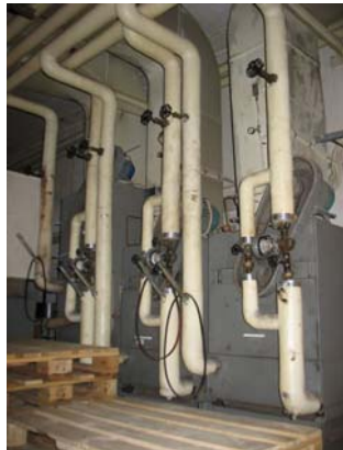
Figur 113. Äldre tryckluftsbaserad ventilation vilken idag används för romerska badet.
