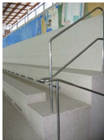
Figur 43. Läktaren med uppböjda sittplatser är helt täckt med mosaik. I framkant av sittplatserna finns ventilationsöppningar.
