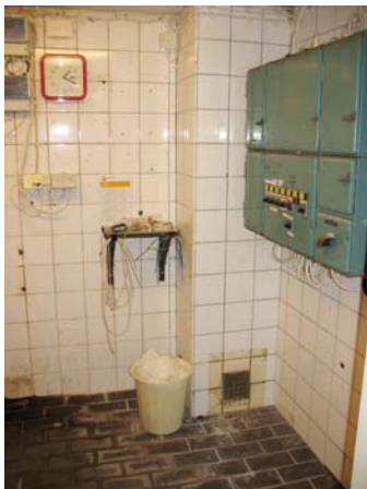
Figur 106. Rum för styrning av bl.a. klorhalten i vattnet.
