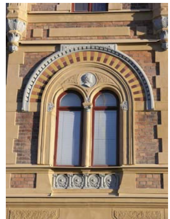
Figur 38. Fönsterparti efter renoveringen med ny färgsättning på överstycket samt åtgärdad medaljong. Foto KM.
