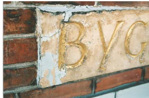
Figur 19. Skador i stuckkapitel i xx hörnet före renoveringen. Foto KM.
