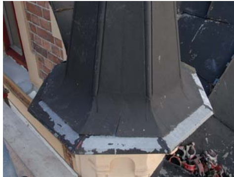
Figur 17. Tornbuv i Zinkplåt före ommålning. Avtäckning nedåt i galvad plåt. Foto KM.
