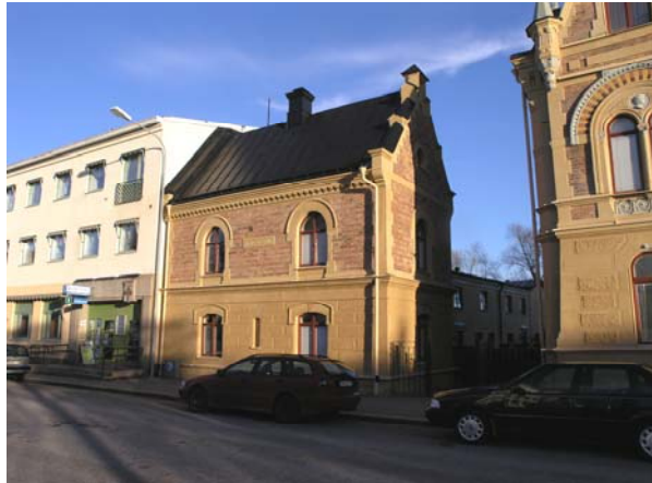
Figur 41. Lilla huset efter renoveringen. Foto: KM.
