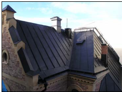
Figur 15. Lilla huset, bakre takfallets plåttak efter ommålning. Foto KM.
