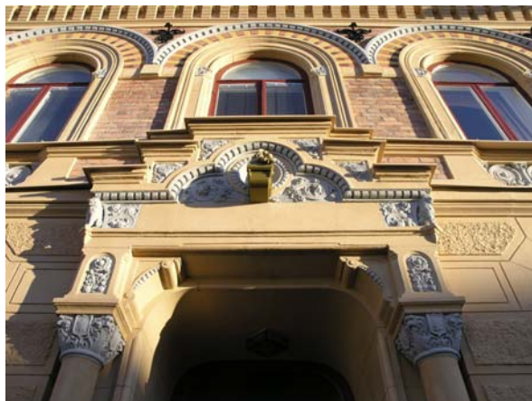
Figur 43. Huvudentrén efter renoveringen. Entrépartiet är målat med linoljefärg enligt ursprungligt utförande. Foto KM
