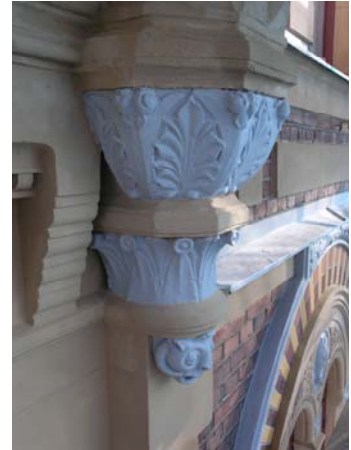
Figur 34. Stuckkapitäl efter renovering och åtgärdande av skador. Foto KM.
