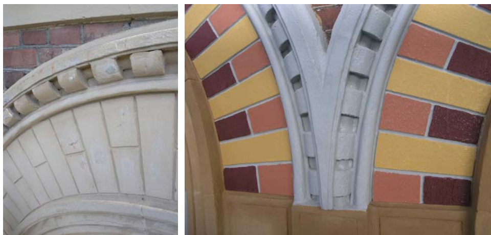
Figur 29. Äldre färgsättning kan anas vid skrapning av fönsteröverstycken. Foto KM.
