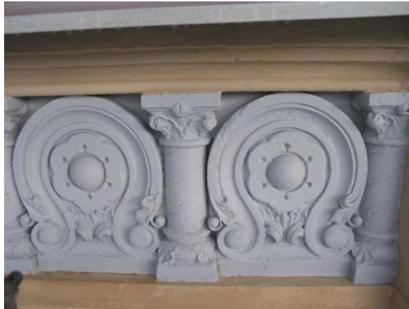
Figur 33. Målning av stuckelement med linoljefärg. Foto KM.
