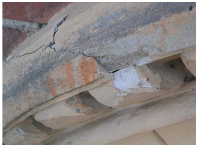
Figur 25. I anslutningen mellan puts och plåt fanns i flera fall problem med skador. Vattenavledningen har inte fungerat tillfredsställande. De saknade delarna av putsdekoren fick i detta fall återskapas. Foto KM.
