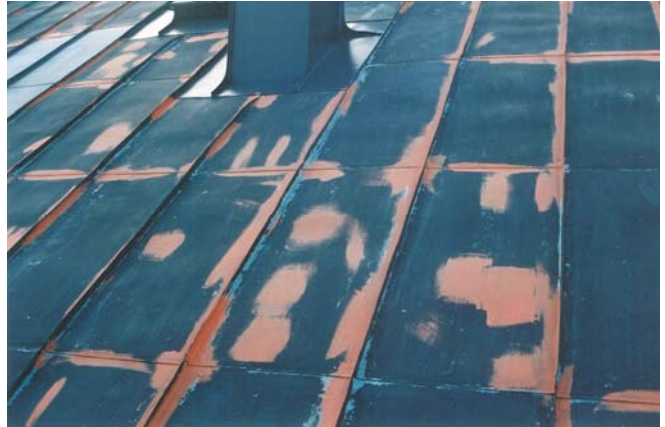
Figur 13. Rostskador i falsarna på takfallet mot gården på stora huset. Foto: KM.
