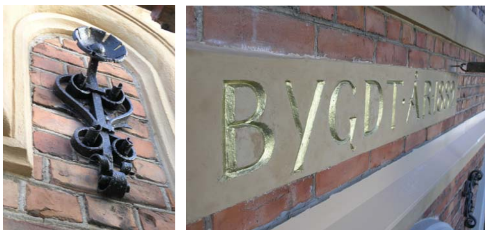
Figur 31. Linoljefärgsmålat ankarlut på fasaden mot gatan. Foto KM.
