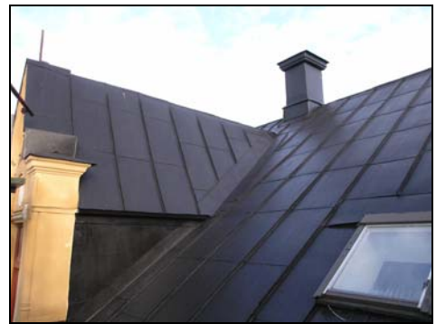
Figur 15. Lilla huset, bakre takfallets plåttak efter ommålning. Foto KM.
