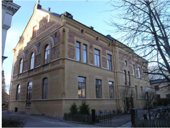
Figur 39. Baksidan efter renoveringen.
