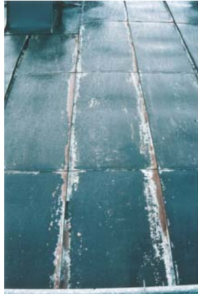
Figur 13. Rostskador i falsarna på takfallet mot gården på stora huset. Foto: KM.
