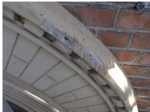
Figur 17. Tornbuv i Zinkplåt före ommålning. Avtäckning nedåt i galvad plåt. Foto KM.
