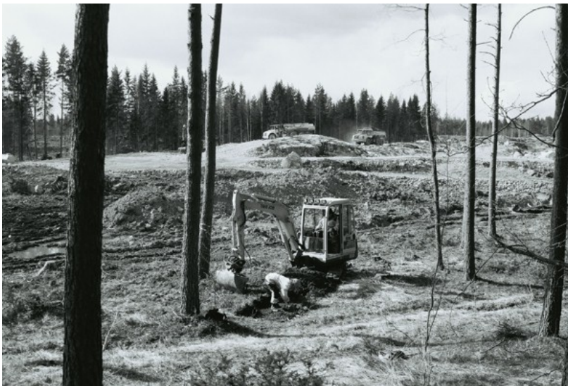
Figur 3. Schaktning på den västra låglänta sidan. Foto från Ö, Karin Nordström.
