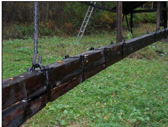
Figur 11. Sydvästra vevaxelarmen där den går samman med stånggången. Efter renoveringen. Virket har skarvats samman med en blixtskarv motsvarande mallen för stånggången.
