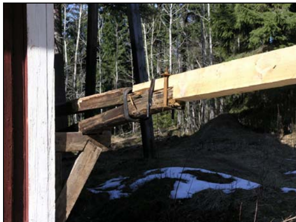
Figur 15. Skarvning halvt i halvt i anslutningen mellan stånggång och nordöstra vevaxelarmen, utförd 2006. I samband med reparationerna 2007 utfördes denna istället som en blixtskarv (se figur 17).
