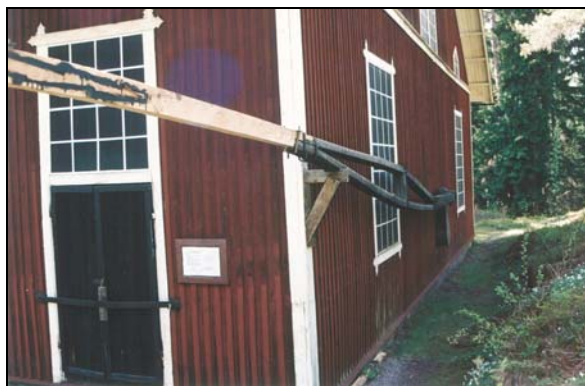
Figur 16. Nordöstra vevaxelarmen efter reparationerna 2006, före åtgärderna 2007.
