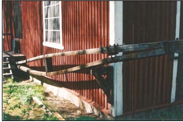
Figur 9. Sydvästra vevaxelarmen före åtgärderna.
