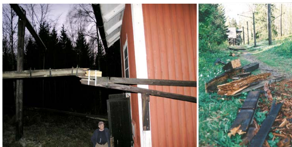
Figur 7. Före renoveringen var stånggången i mycket dåligt skick. Bland annat hade den brustit i anslutning till den nordöstra vevaxelarmen. Man kan dock konstatera att anslutningen är gjord med en blixtskarv.
