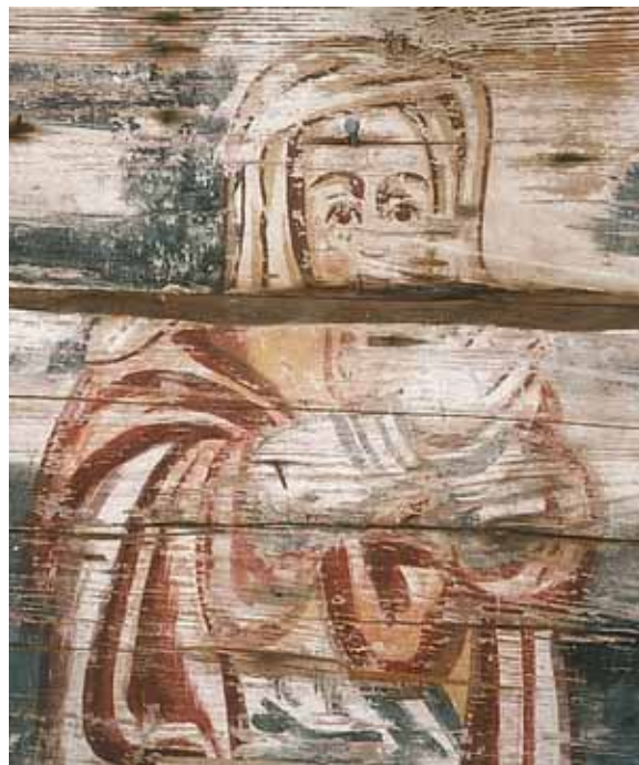
Figur 5. Delar av ett trätunnvalv troligen från 1600-talet med en Mariabild. Mariabilden som finns på kyrkans vind var oskadad efter branden (foto Ulf Alström).
