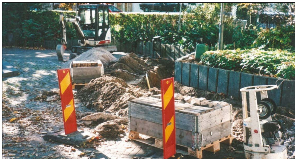
Figur 2. Bild från schaktningarna vid fontänen i Stadsparken (foto U. Alström).
