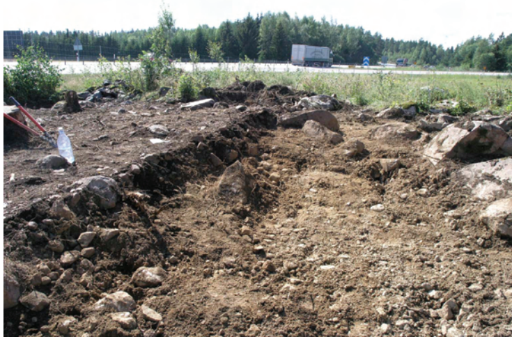
Figur 4. Den norra halvan av naturbildningen är bortschaktad. Foto fr norr A-L Hallgren.
