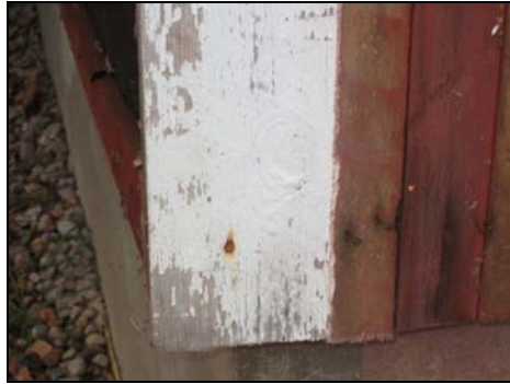
Figur 15. Knutbräda i liv med fasadens panel. Foto: Helén Sjökvist. Figur. Gammal träullsisolering. Foto: Helén Sjökvist.
