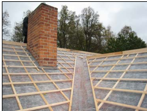
Figur 9. Undertak är omlagt och läkten ny. Foto: Helén Sjökvist. Figur 10. Nytt skärmtak över verandan samt den gamla ytterdörren. Foto: Helén Sjökvist.
