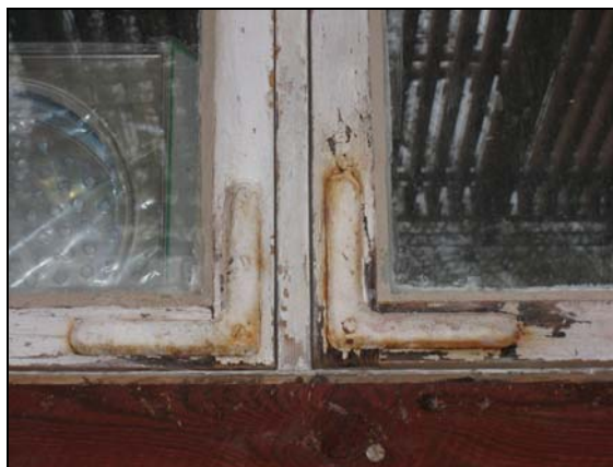
Figur 13. Detalj av hörnjärn på fönster på östra fasaden före renovering. Foto: Helén Sjökvist. Figur 14. Fönster på östra fasaden före renovering. Foto: Helén Sjökvist.
