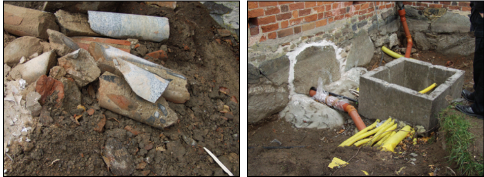
Figur 33. Borrkärnor, bland annat från borrhningen genom sakristians grund. Foto: Helén Sjökvist. Figur 34. Muren återställd. Rören dras via en dragbrunn för att minimera behovet av rör som skall dras in genom grundmuren. Foto: Helén Sjökvist.
