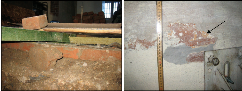
Figur 15. Nuvarande trägolv i sakristian är lagt på regler, troligen behandlade med cuprinol eller liknande, vilka ligger på en plast över tegelgolvet från 1803. Foto: Helén Sjökvist.
