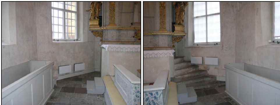
Figur 19. Nya radiatorer i korets nordöstra del samt ny sockel för att dölja eldragningarna. Foto: Helén Sjökvist.
