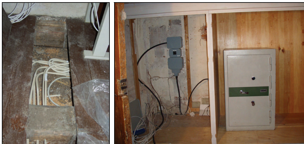
Figur 11. Dragning av nya elkablar i bjälklaget. Foto: Helén Sjökvist.
