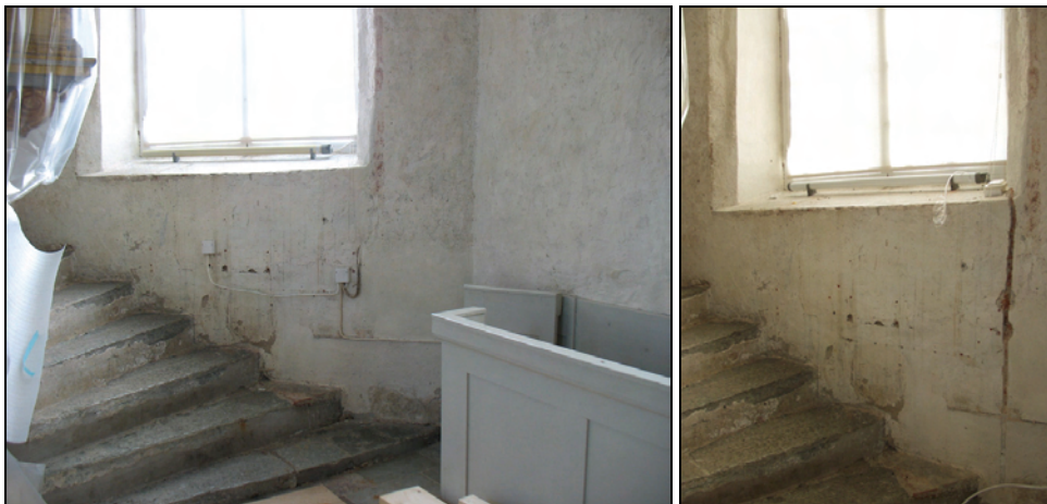
Figur 5. Installationer vid sydöstra fönstret före åtgärder i putsen. Den befintliga radiatorn är borttagen men en mängd installationer finns kvar på denna bild. Hålen efter dessa har åtgärdats av konservator. Foto: Helén Sjökvist.
