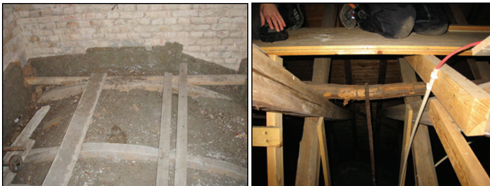
Figur 29. Takstol över tornrummet före överbyggnad med plattform. Foto: Helén Sjökvist. Figur 30. Upphängning av främre takkronan. Foto: Erik Sörbring.
