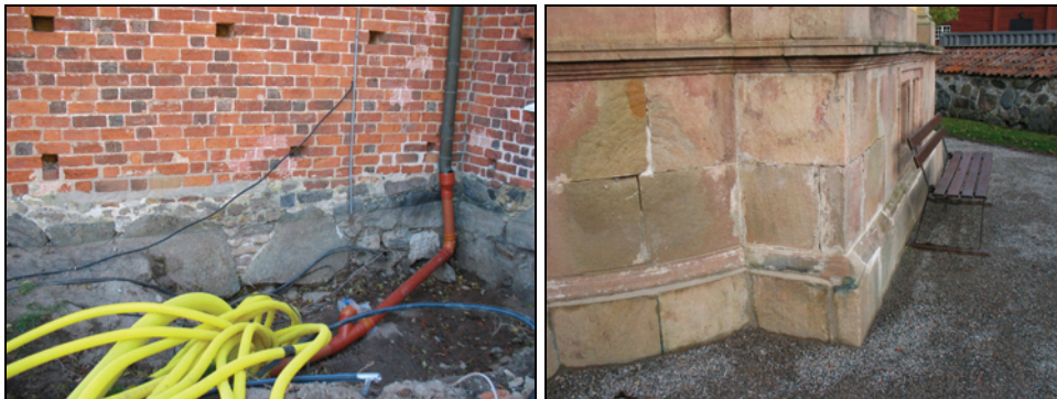
Figur 31. Öppning för rör in till sakristian via dragbrunn. Foto: Helén Sjökvist. Figur 32. Omfogade grundmurar på Piperska gravkoret före införing av fogbruk. Foto: Helén Sjökvist.
