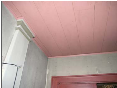
Figur 69. Kilsågade bräder i tak i vindfånget mellan vapenbus och långhus före nedmontering.
