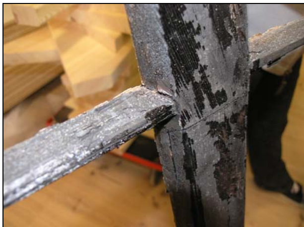
Figur 85. Kolningen har gått en bit in i spröjsens trä på innerbågens insida.
