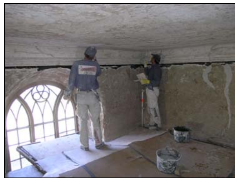
Figur 61. Nedfräsning av yttersta puts-skiktet från väggarna. Foto: Rolf Hammarskiöld.
