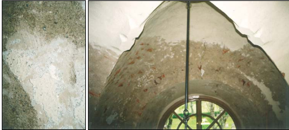
Figur 16. Rester av rosa kulör i vapenhusets valv, södra sidan.
