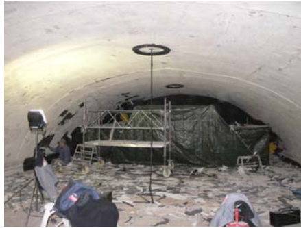
Figur 65. Nedskrapning av nedsotad microlite i tunnvalvet.
