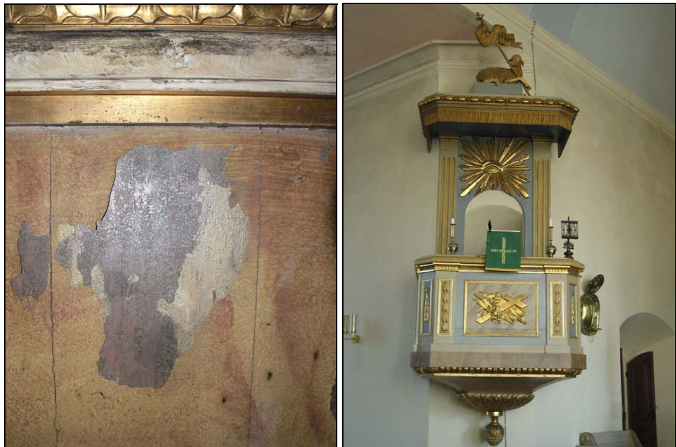
Figur 41. Skadad färg på altaruppsatsens pälster samt vit, krederad yta på kapitälens nedre del. Man kan här ana hur färgskiktet från 1970-talet släpper i stora flagor. Foto: Anders Persson.
