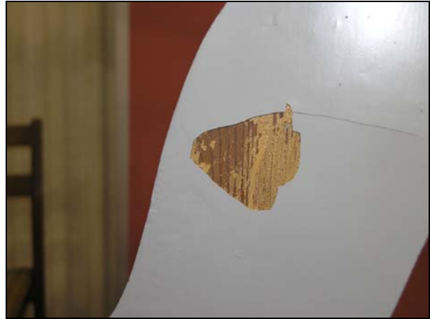
Figur 24. Under befärdig målning på bänkarna syns den äldre ekådringen. Sidostyckets fasade kanter har en kraftigt rödbrun ton medan övriga delar av bänken tycks vara ådringsmålad.
