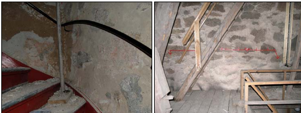
Figur 14. Rester av rosa kulör i läktartrappan. Figur 15. I tornet syns rester av den äldre putsen på den gamla västfasaden. Därför avgränsades denna del inför kolsyreblästringen i tornet.
