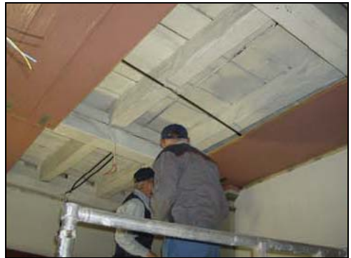
Figur 69. Kilsågade bräder i tak i vindfånget mellan vapenbus och långhus före nedmontering.
