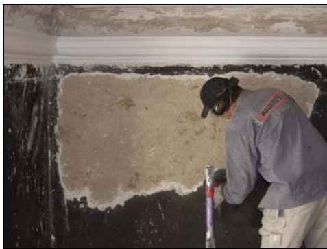
Figur 61. Nedfräsning av yttersta puts-skiktet från väggarna. Foto: Rolf Hammarskiöld.
