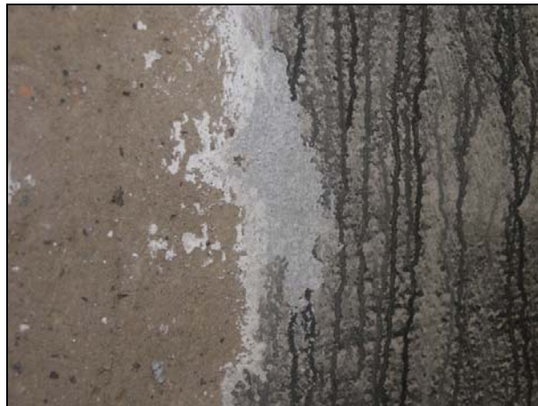
Figur 63. Putsen delvis bortfräst i sakristian. Texttavlan över dörröppningen har sparats ur.
