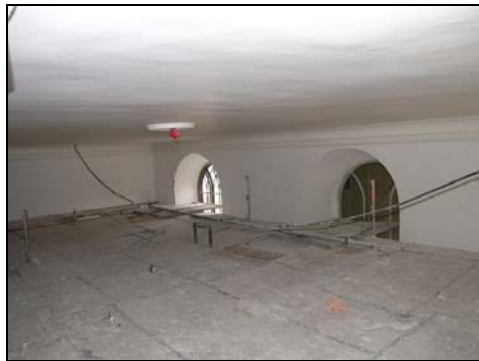
Figur 67. Taket i norra korsarmen efter åtgärderna.
