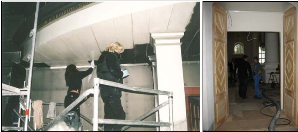
Figur 71. Rengöring av läktarens undersida med hjälp av såpvatten.
