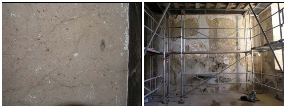
Figur 8. Den gamla putsen från 1790-talet innehöll bitar av slagg, tegel och trä.
