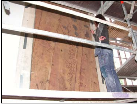
Figur 34. Kalkering av altaruppsatsens befintliga marmorering från 1975. Foto: Anders Persson. Figur 35. Äldre färgsättning på pilasterbas. Foto Anders Persson.
