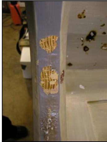
Figur 24. Under befärdig målning på bänkarna syns den äldre ekådringen. Sidostyckets fasade kanter har en kraftigt rödbrun ton medan övriga delar av bänken tycks vara ådringsmålad.
