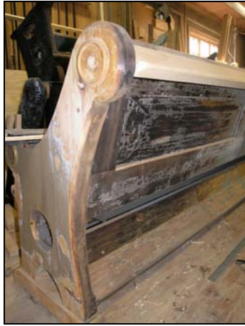
Figur 81. Bränd baksida på bänk samt utbytt psalmboksbräda och fot.
