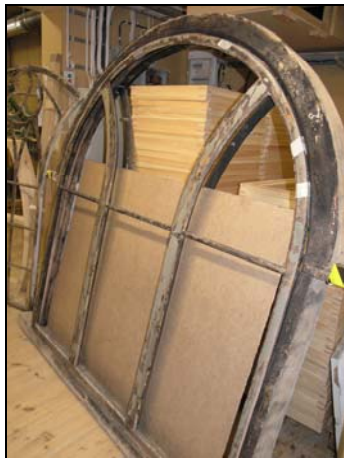
Figur 85. Kolningen har gått en bit in i spröjsens trä på innerbågens insida.
