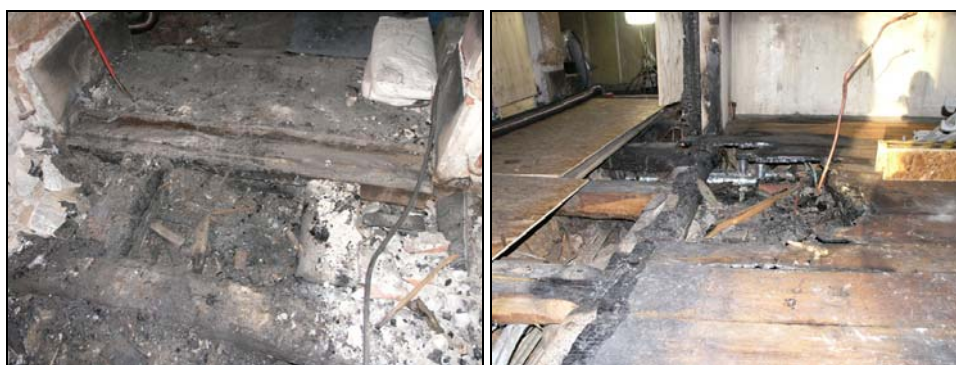
Figur 57. Tröskeln och bjälkarna närmast norra porten var mycket brandskadade samt även rötskadade varför de byttes.
