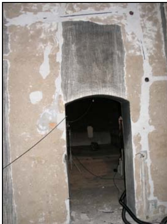
Figur 63. Putsen delvis bortfräst i sakristian. Texttavlan över dörröppningen har sparats ur.
