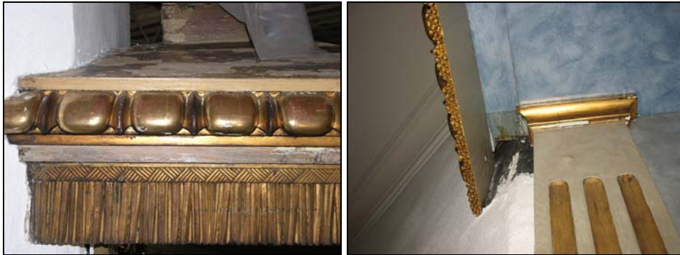
Figur 75. Baldakinens polymerförgyllningar fästes ned.
