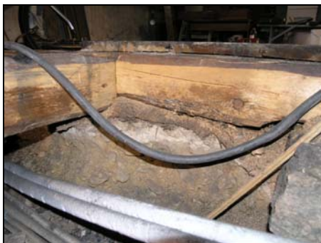
Figur 6. Lerpäckning under golvbjälke vid norra entrén.
