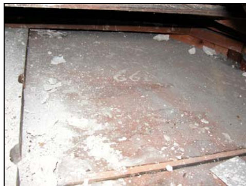
Figur 45. Baldakintaket med äldre färgsättning. Vid tumstockens vänstra del syns den triangel av originalfärg som bevarats under lammets fot. I övrigt syns även den ljusa färg som tillkommit vid renoveringen 1887 och vad som fanns kvar av 1975 års färgskikt.
