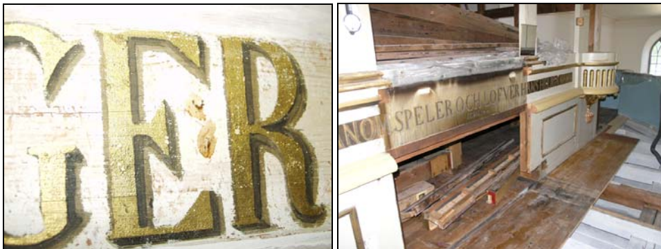
Figur 79. Blåsor i förgyllningen på grund av värmen vid branden.
