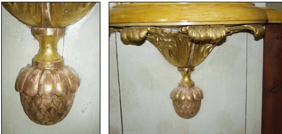
Figur 77 Orgelfasaden, södra pinjekotten med tvättskador.
