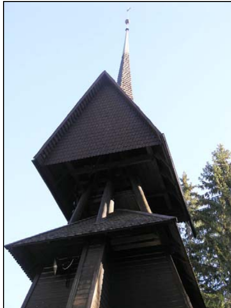
Figur 12. På sidorna har spånet inte bytts ut. Foto: Helén Sjökvist.
