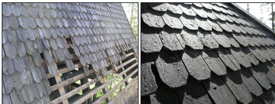
Figur 6. nedplockning av spån på norra övre takfallet. Foto: Helén Sjökvist.
