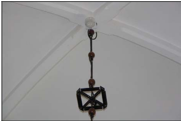
Figur. Branddetektor monterad mot ett vitmålat bleck som fästs mot kronan.
