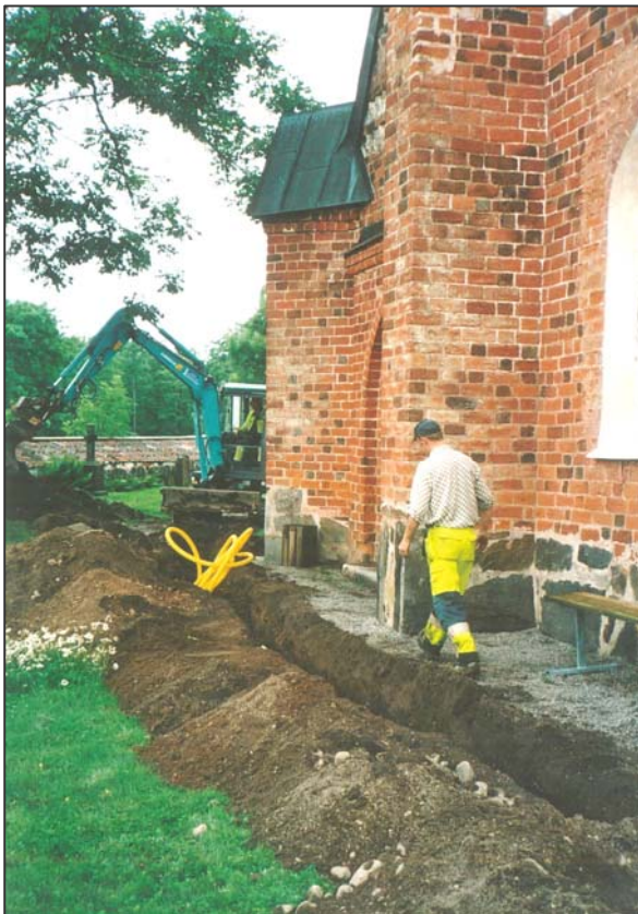
Figur 8. Grävning runt kyrkan. I jordmassorna förekom det ytters lite ben vilket får skyllas att berget ställvis låg grunt. Därför kunde heller inte många gravplatser av rent praktiska skäl grävas intill kyrkan. (Foto U. Alström).
