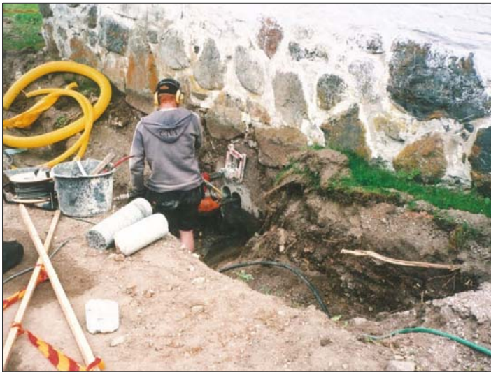
Figur 11. Borring för kablar genom kyrkogårdsmurens undergrund. (Foto U. Alström).
