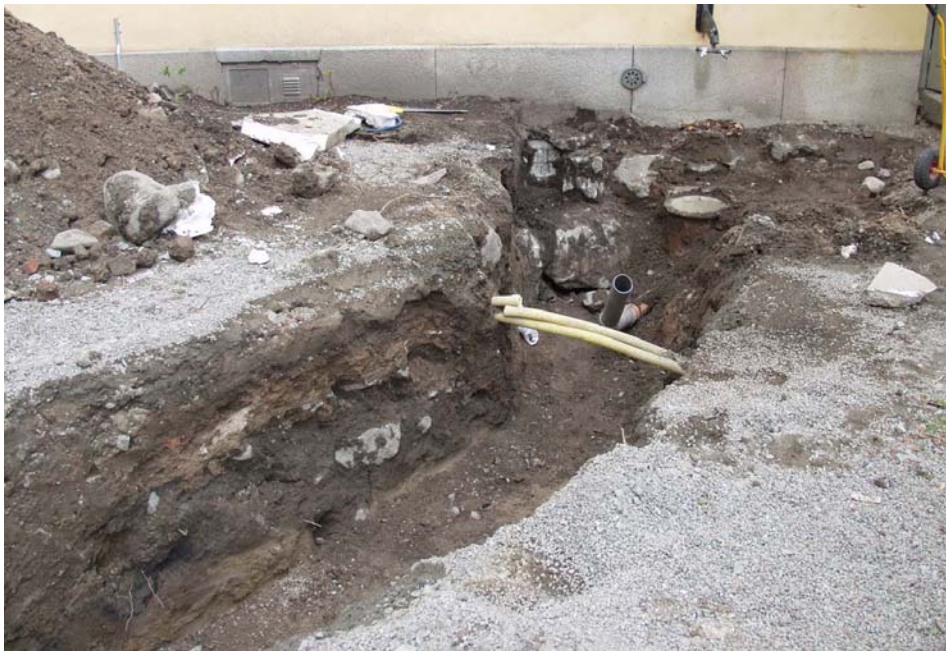
Figur 3. Schakt 1 fotograferat från nordväst. I schaktväggen syns de bevarade lagren som dokumenterades genom sektionsritning. Foto: Kristina Jonsson.
