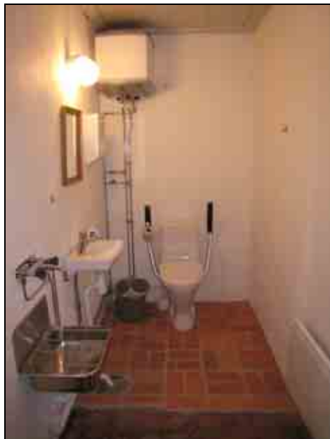
Figur 13. Den tidigare WC-väggen är riven. Klinkergolvet är bytt mot ett handslaget tegel. Foto: Helén Sjökvist. Figur 14. Puttskadan under fönstret är åtgärdad. På väggen är ett skötbord monterat. Foto: Helén Sjökvist.
