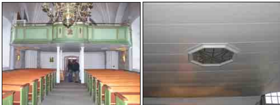
Figur 4. Läktaren före uppförandet av en läktarunderbyggnad. Foto: Helén Sjökvist.
