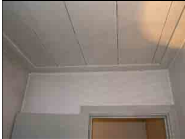
Figur 11. Anslutning mellan tak och mellanvägg i det tidigare kapprummet. Foto: Helén Sjökvist. Figur 12. Tidigare klinkergolv på WC. Foto: Helén Sjökvist.
