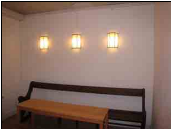
Figur 21. I läktarunderbyggnaden har bland annat en äldre kyrkbänk satts in. Lampetterna på väggen är gamla armaturer som renoverats. Foto: Helén Sjökvist.
