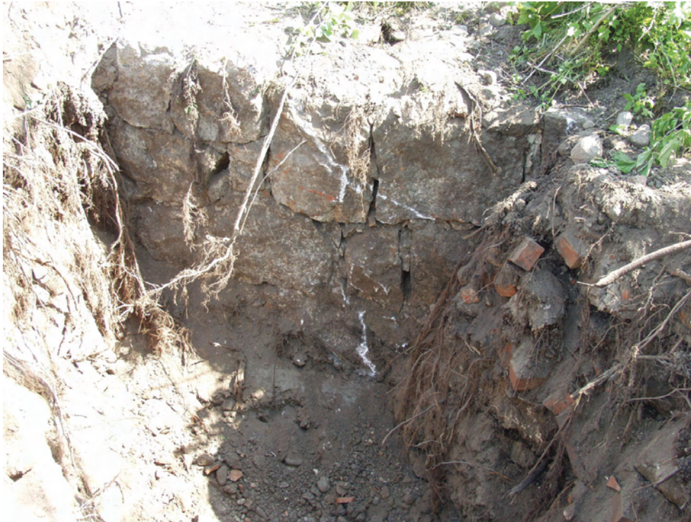
Figur 4. Husgrunden i schakt 4. Foto från söder av Kristina Jonsson.
