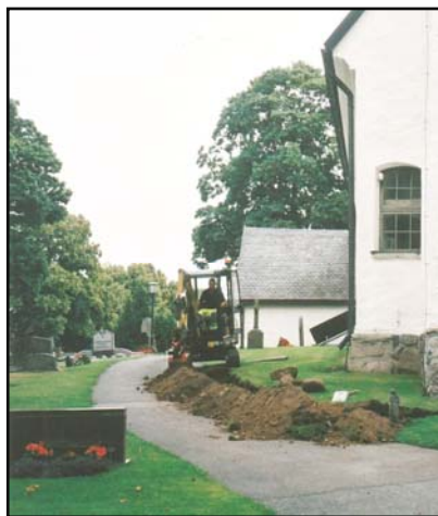
Figur 3 och 4. Schaktningsarbetet vid Hallsbergs kyrka. På bilderna syns bl.a. rören för bergvärmen. (Foto U. Alström.)
