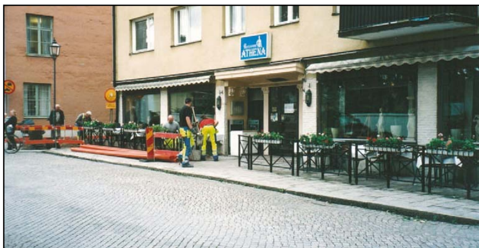
Figur 3. Handgrävning av rörschaktet vid Rådhusgatan var nödvändigt eftersom det berörde en uteservering. (Foto U. Alström.)
