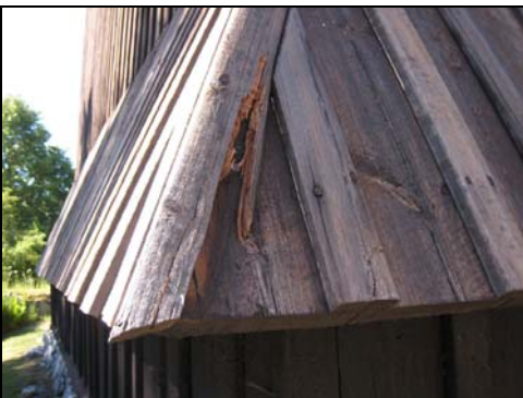
Figur 5. Västra sidan på klockstapeln hade spräckor och små rötskador i panelen vilket åtgärdades. Foto: Helén Sjökvist.
