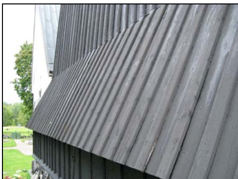
Figur 7. Västra sidan efter åtgärder. Rötskadad panel utbytt. Foto: Helén Sjökvist.
