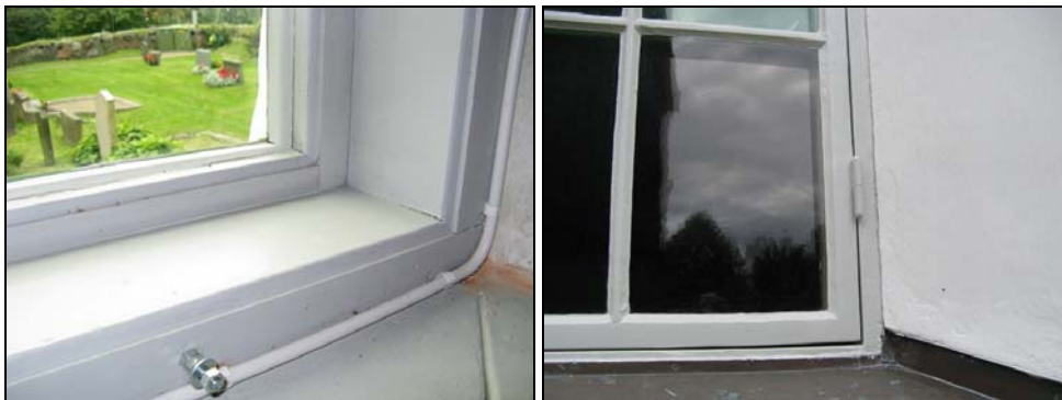
Figur 14. Fönster efter ommålning av insidans karmbottenstycke. Foto: Helén Sjökvist.
