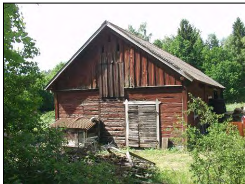
Figur 47. Östra gaveln före åtgärder.
