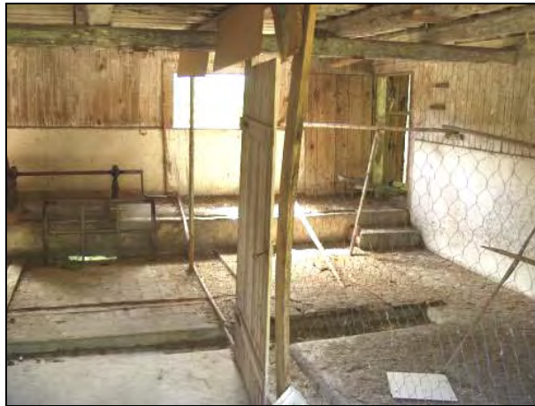
Figur 7. Interiör i ladugården med plats för hönsen. I bildens nedre del syns även den timmerlagning som utförts i ladugårdens nordvästra hörn.
