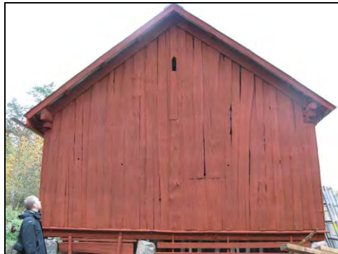
Figur 45. Västra fasaden efter åtgärder med infäst panel.
