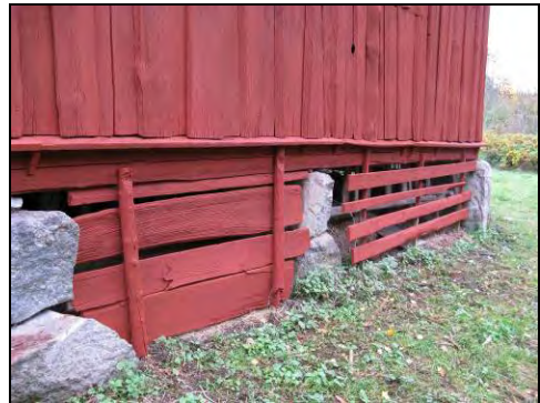
Figur 46. Grindar under byggnaden är reparerade och rödfärgade.
