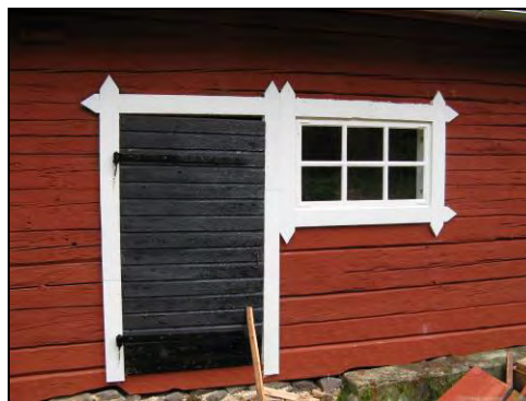
Figur 29. Ny karm och båge samt timmerlagning under fönsterbågen. Norra fasadens västra fönster sett inifrån.
