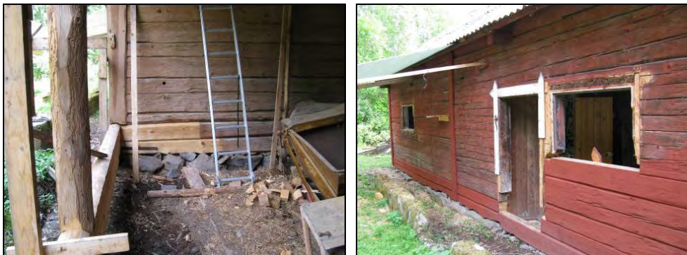
Figur 17. Timmerlagning i ladugårdsdelens nordvästra parti. I hörnet anas ett hörnjärn som stärker sammanfogningen.
