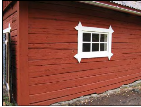
Figur 27. Ny karm och båge samt timmerlagning under fönsterbågen. Norra fasadens östra fönster sett inifrån. Spikteglet är delvis demonterat för att komma åt att göra timmerlagningar.
