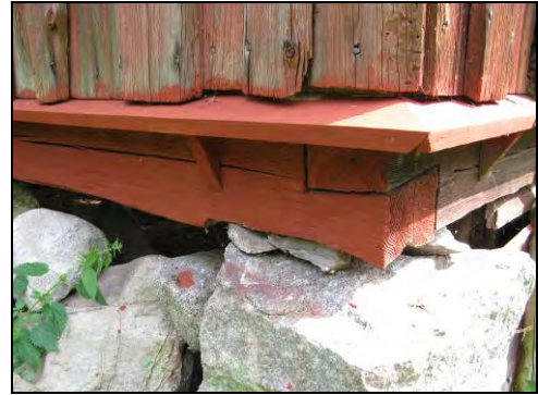
Figur 44. Ny vattbräda med samma typ av underliggande stöd som tidigare.
