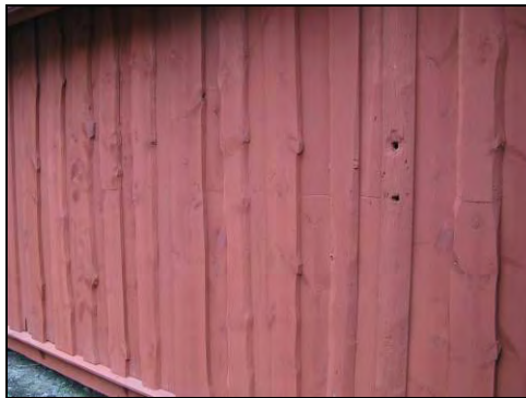
Figur 32 Norra fasaden, öster om logdörrarna, har delvis kompletterats med nytt kilsågat virke samt skarvats samman.
