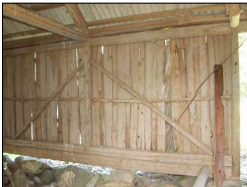
Figur 9. Logens stomme är uppförd i stolpverksteknik.
