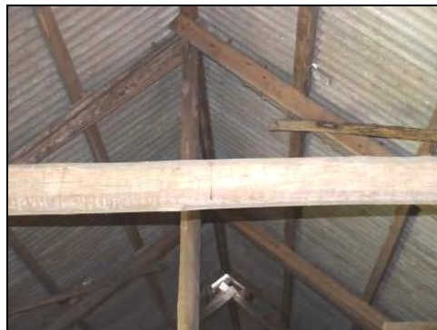
Figur 10. Takstolen gör troligt att byggnaden täckts med vass- eller halmtak.
