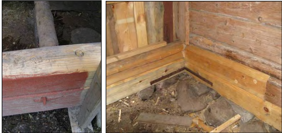
Figur 21. Det nya timrets yta har bilats och delarna har sammanfogats med dymlingar. Figur 22. Logens nordöstra hörn med timmerlagning även av ladugårdens timmerstomme. Hörnjärnet är hittat på marken inne i logen och har återanvänts.
