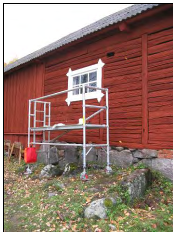
Figur 35. Södra fasaden, ev. igensatt öppning eller skarvning mellan byggnadsdelar, utförd med gåt och svärd. Antydning finns till en körbro upp mot grunden.
