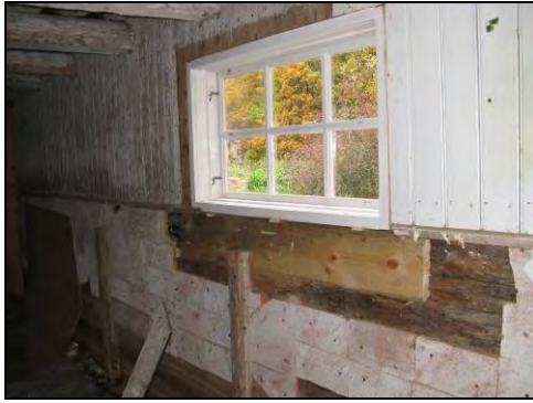
Figur 27. Ny karm och båge samt timmerlagning under fönsterbågen. Norra fasadens östra fönster sett inifrån. Spikteglet är delvis demonterat för att komma åt att göra timmerlagningar.
