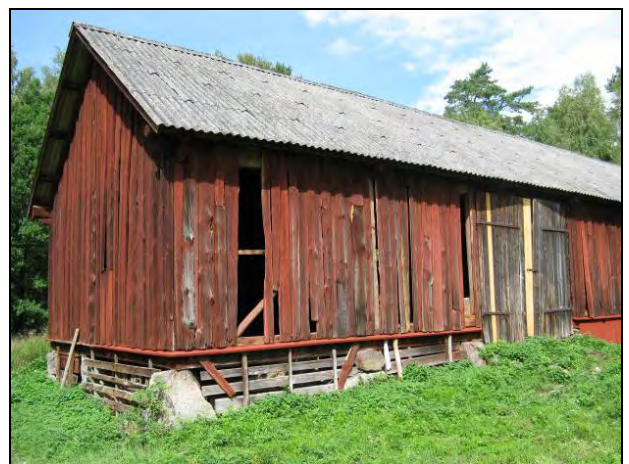
Figur 35. Södra fasaden, ev. igensatt öppning eller skarvning mellan byggnadsdelar, utförd med gåt och svärd. Antydning finns till en körbro upp mot grunden.
