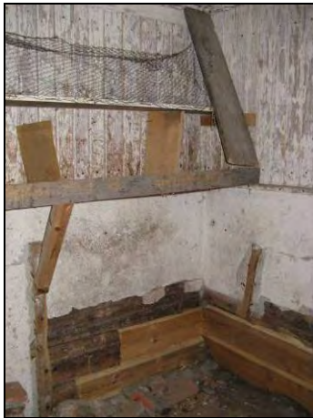
Figur 7. Interiör i ladugården med plats för hönsen. I bildens nedre del syns även den timmerlagning som utförts i ladugårdens nordvästra hörn.
