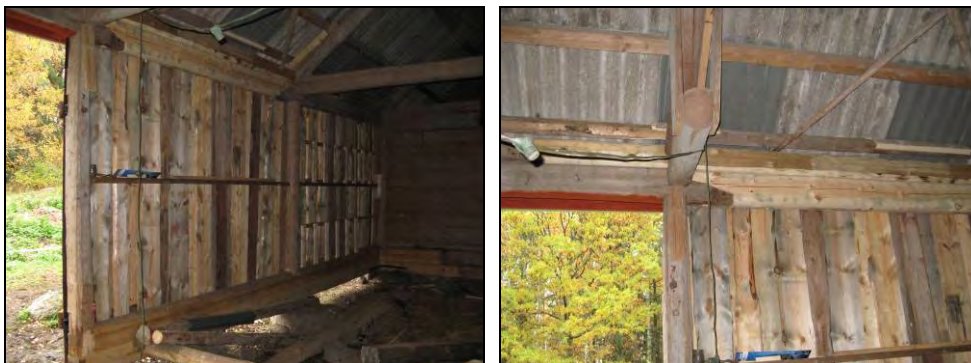
Figur 19. Norra fasaden efter byte av syllstock och hammarband.
