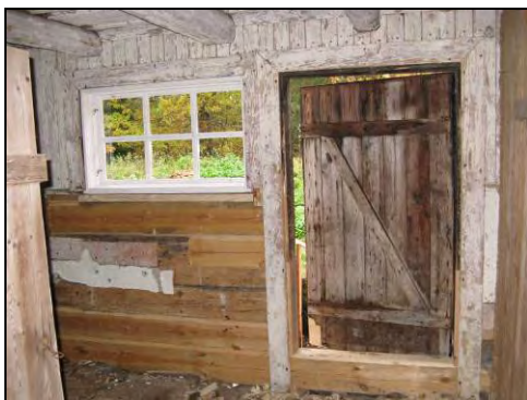
Figur 29. Ny karm och båge samt timmerlagning under fönsterbågen. Norra fasadens västra fönster sett inifrån.
