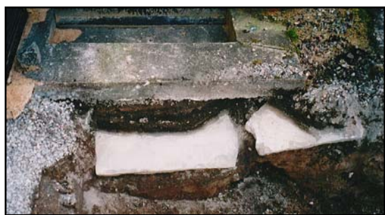
Figur 8. De ljusa slitna kalkstenarna som nu gör tjänst som trappunderlag. (Foto U. Alström.)
