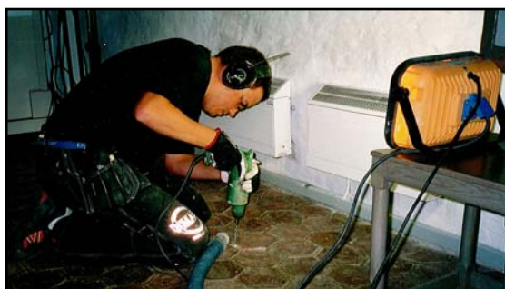
Figur 10. Arbete med borttagande av sexkantiga tegelstenar från den övre golvnivån vid provplats sju. (Foto U. Alström.)
