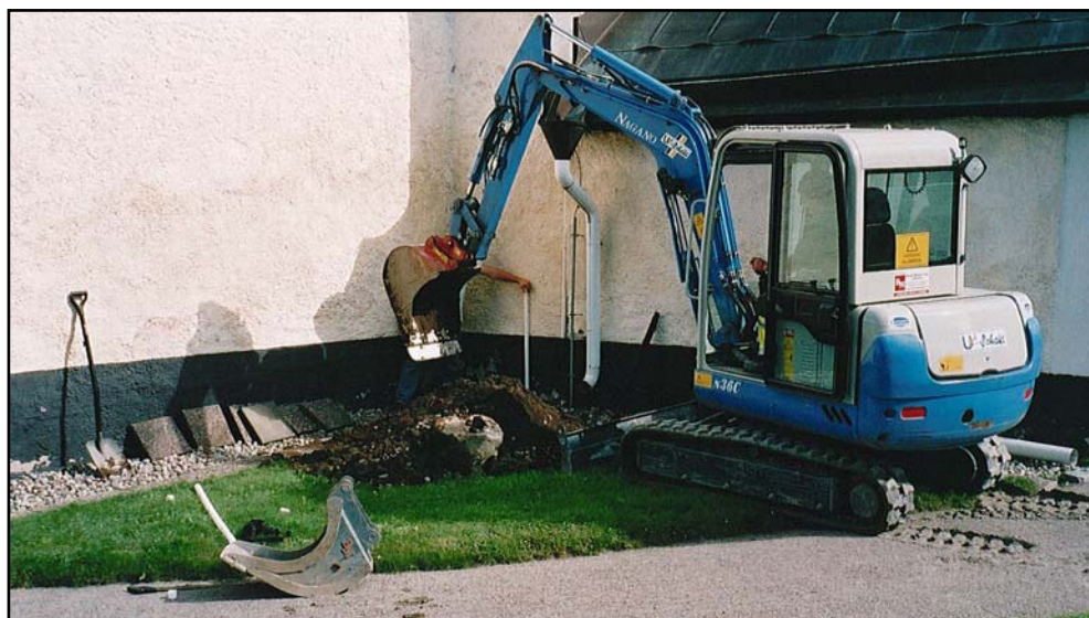
Figur 6. Schaktning väster om vapenhuset vid provplats 5. Grävarbetet utfördes av Fastighetsförvaltningen, Västerås kyrkliga samfällighet. (Foto U. Alström.)
