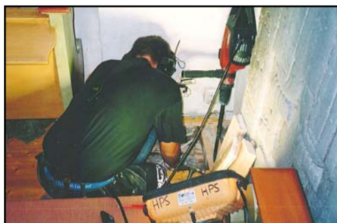
Figur 11. Arbete med borttagande av trägolvet vid provplats nio. (Foto U. Alström.)
