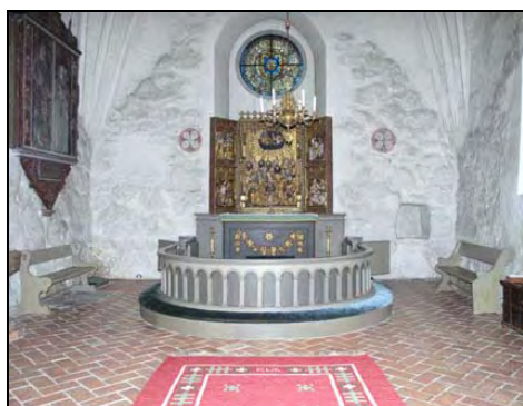
Figur 2. Kraftigt nedsmutsade väggar i koret före rengöringen. Naturstenen som ingår i väggarna framträder tydligt.
