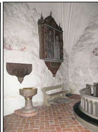
Figur 2. Kraftigt nedsmutsade väggar i koret före rengöringen. Naturstenen som ingår i väggarna framträder tydligt.
