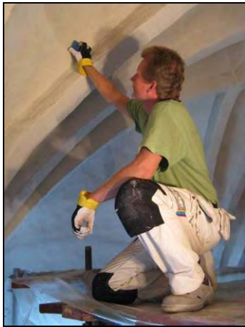
Figur 6. Rengöring av valv pågår.
