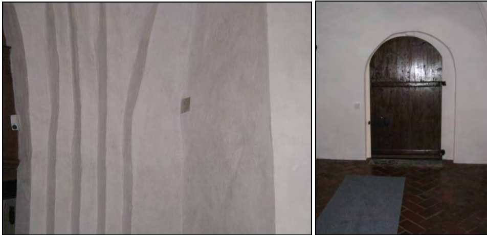
Figur 20. En provruta lämnades på den norra väggen för att visa på skillnaden mellan rengjord och icke rengjord yta.
