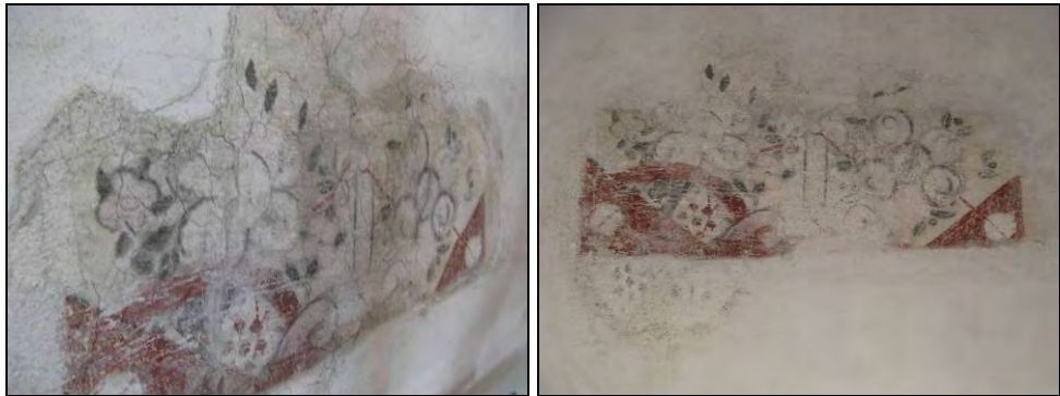
Figur 26. Renässansmålning på korets norra vägg före rengöring.
