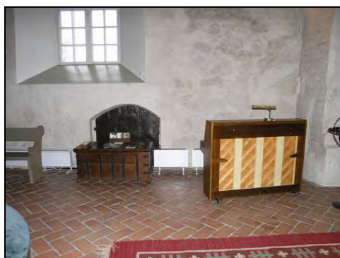
Figur 2. Kraftigt nedsmutsade väggar i koret före rengöringen. Naturstenen som ingår i väggarna framträder tydligt.
