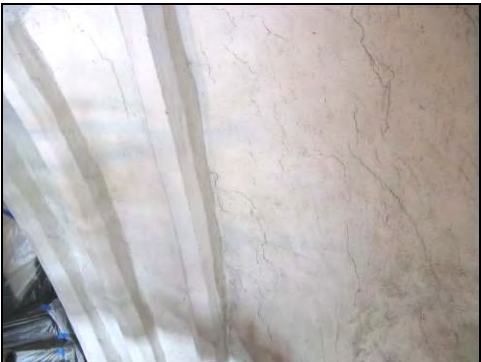
Figur 10. Sydöstra delen av korvalvet med missfärgningar av mögelangrepp.
