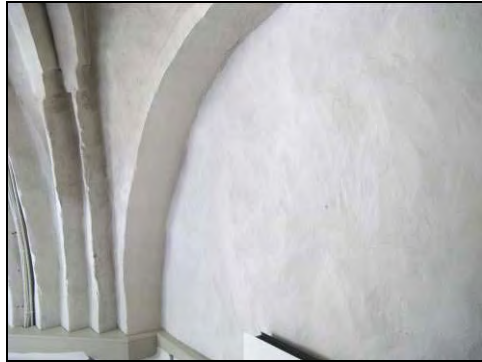
Figur 12. På orgelläktaren hade nischerna sedan tidigare målats med kalkfärg våt. Figur 13. Korvalvet rengjort och laverat en gång.
