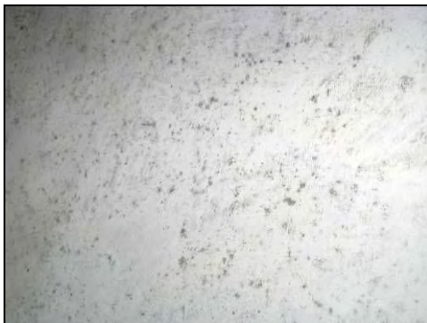
Figur 8. Korvalvets nordvästra hörn. Omfattande missfärgningar på grund av mögelangrepp.
