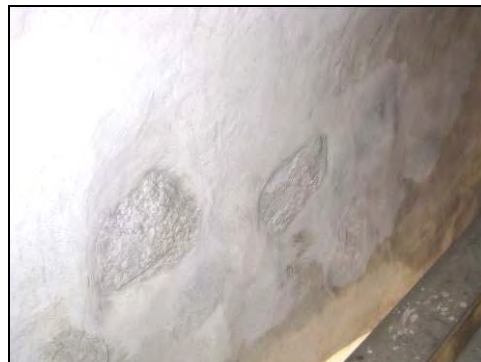
Figur 8. Korvalvets nordvästra hörn. Omfattande missfärgningar på grund av mögelangrepp.
