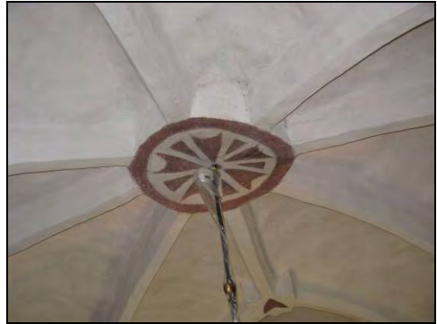
Figur 12. På orgelläktaren hade nischerna sedan tidigare målats med kalkfärg våt. Figur 13. Korvalvet rengjort och laverat en gång.
