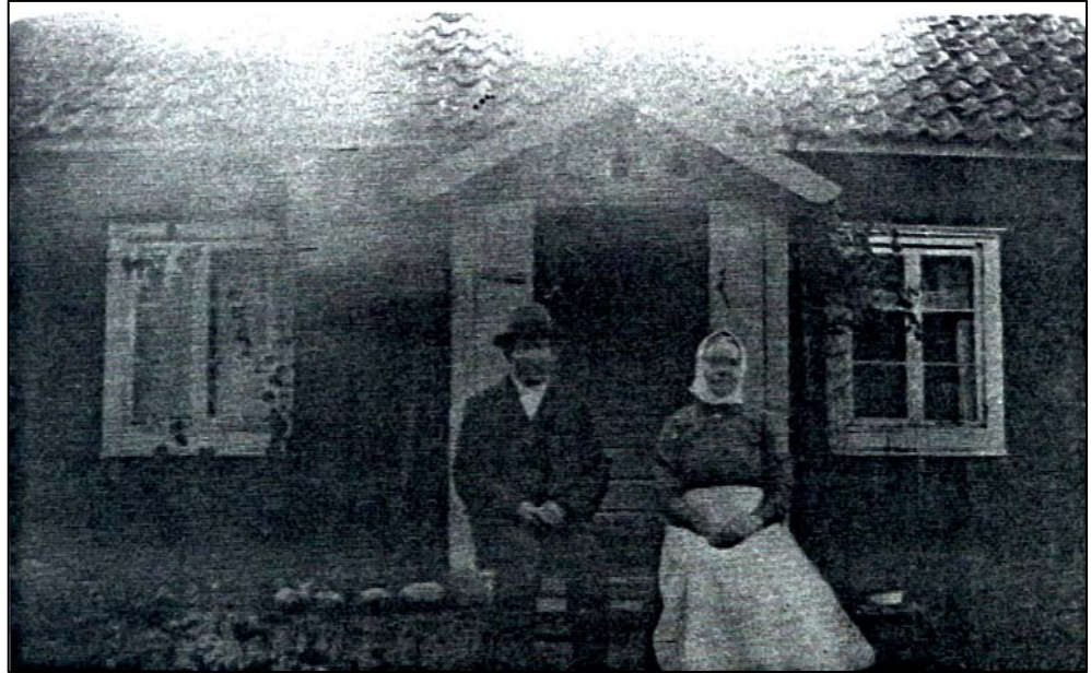
Figur 109. Axel Johanssons föräldrar utanför den nyare stugan vid Kalvstorp, bostadshuset på 1911 års karta (objekt 9, fig. 113). Stugan är lite mer påkostad än undantagsstugan (fig. 106). Den har en liten förstukvist och omfattningar kring fönstren. Troligtvis fotograferat från öster.
