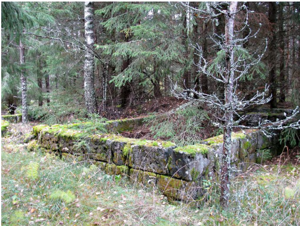
Figur 13. Husgrund i slaggsten efter torpet Dammossen i Västervåla socken. Foto: Ronnie Jensen, 2008-10-03.
