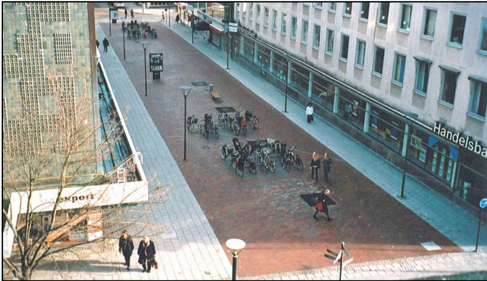
Figur 10. Smedjegatan efter avslutat arbete. September 2008. (Foto U. Alström.)
