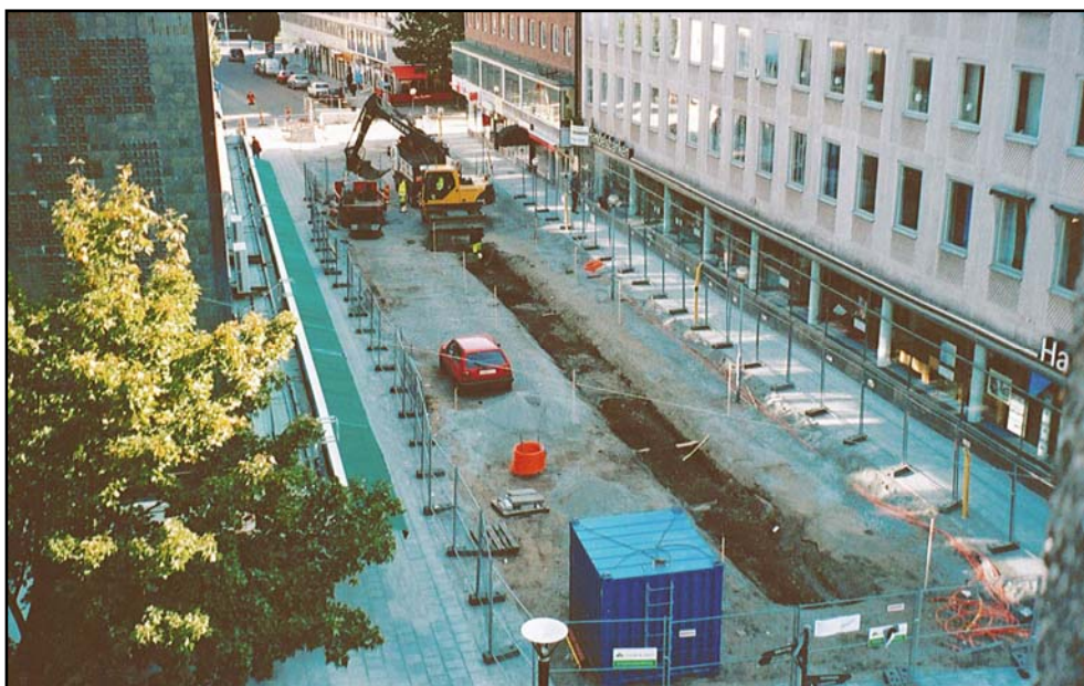
Figur 8. Vy från Arosians tak. Schaktet för trädplanteringsgroparna och skelettjorden är cirka 70 m långt och 2,4 m brett. (Foto U. Alström.)
