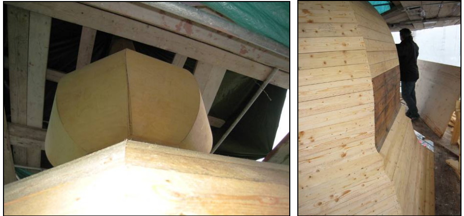
Figur 85. Spiran rekonstruerades efter den dokumentation som utförts vid nedblockningen. Foto: Helén Sjökvist.
