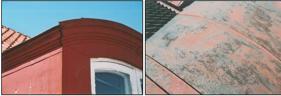
Figur 65. Takkupa med profilerad plätgesims. Foto: Helén Sjökvist.
