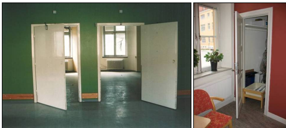
Figur 28. I rundlarna fanns lägenheter för underläkarna med familjer. Bild från före renoveringen. Foto: Helén Sjökvist.
