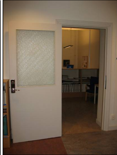
Figur 39. Ny spegelindelad dörr med nytt dörrtrycke. Foto: Helén Sjökvist. Figur 40. Dörr med råglasruta efter renoveringen. Foto: Helén Sjökvist.
