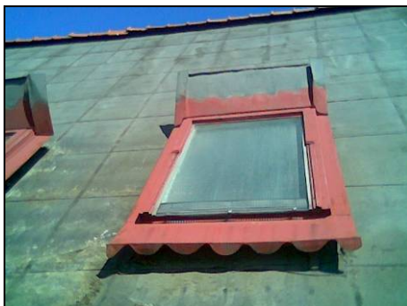
Figur 79. Två senare tillkomna takfönster på huvudfasaden avlägsnades för att minska risken för läckage. Foto: Helén Sjökvist.
