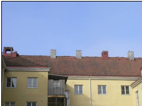
Figur 93. Ventilationshuvarna visade sig då de täcktes av vara murade med lättbetongsten. Foto: Helén Sjökvist.
