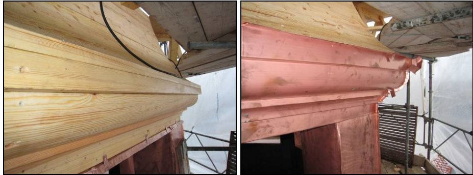
Figur 83. Profileringen på tornhuvens gesims utfördes som en kopia av befintlig. Foto: Helén Sjökvist.
