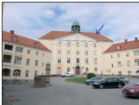
Figur 79. Två senare tillkomna takfönster på huvudfasaden avlägsnades för att minska risken för läckage. Foto: Helén Sjökvist.
