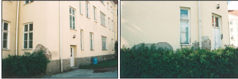
Figur 49. Västra flygeln stort putsbortfall i nedre delen av hörnet mot rundel. Foto: Helén Sjökvist.
