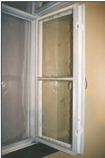
Figur 30. Renoverat fönster med ny innerruta av energiglas. Foto: Helén Sjökvist.
