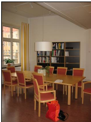
Figur 36. Ett av de tidigare väntrummen efter renoveringen. Taket är sänkt i korridoren samt en bit in i rummet. Längst in mot fönstret behölls ursprunglig takhöjd. Foto: Helén Sjökvist.
