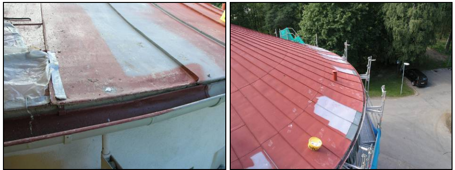
Figur 31. Lödning av mindre hål i nederkant av plåten på östra rundeln. Foto: Helén Sjökvist. Figur 62. Lagningar genom lödning genomfördes på flera ställen i nederkant av plåten på östra rundeln. Foto: Helén Sjökvist.
