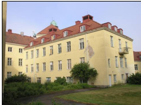
Figur 106. Fasad 3c med omfattande putsbortfall vid stuprör före åtgärder. Foto: Helén Sjökvist.
