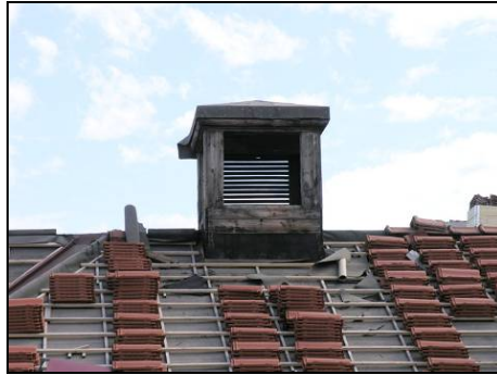
Figur 72. Nyläggning av tegel. Avtäckta ventilationsbuv. Foto: Helén Sjökvist.
