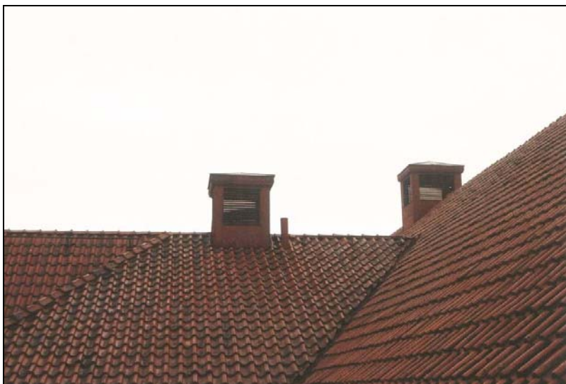
Figur 71. Ventilationshuvar och tegeltak före renoveringen. Foto: Helén Sjökvist.
