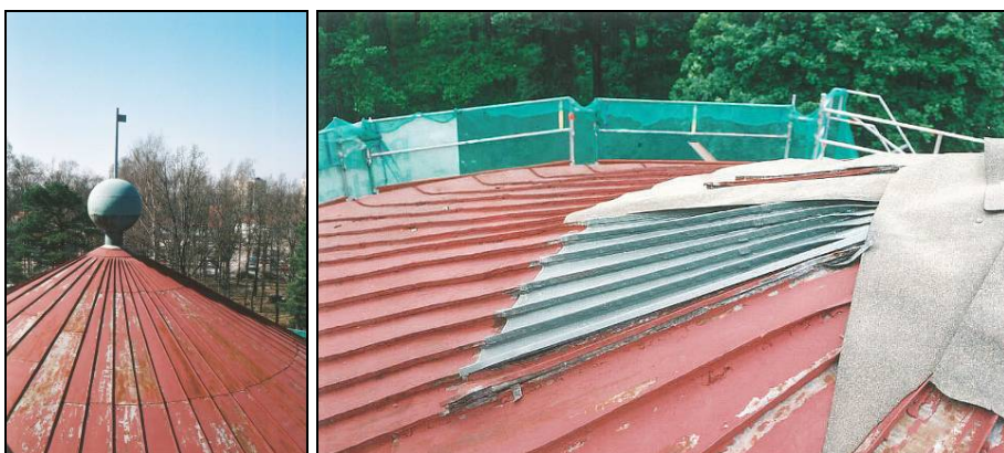
Figur 58. Ytrost på den östra rundelns tak. Foto: Helén Sjökvist.
