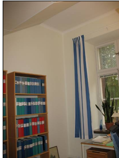
Figur 41. Kontorsrum på västra flygelns nedre plan. Foto: Helén Sjökvist. Figur 42. Takböjden har sänkts fram till strax före fönsternischen för att inrymma ventilation. inne i nischen syns ursprunglig takböjd. Foto: Helén Sjökvist.
