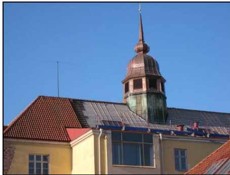
Figur 110. Takfönster med gjutjärnsbågar på byggnad 75. Foto: Helén Sjökvist.
