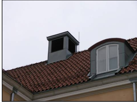
Figur 72. Nyläggning av tegel. Avtäckta ventilationsbuv. Foto: Helén Sjökvist.
