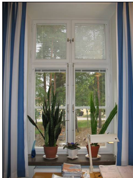
Figur 30. Renoverat fönster med ny innerruta av energiglas. Foto: Helén Sjökvist.
