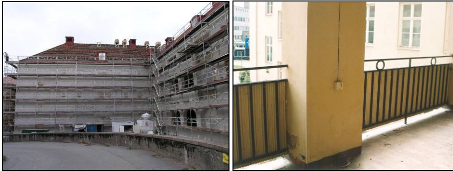
Figur 54. Omputsningen är påbörjad. Foto: Helén Sjökvist.
