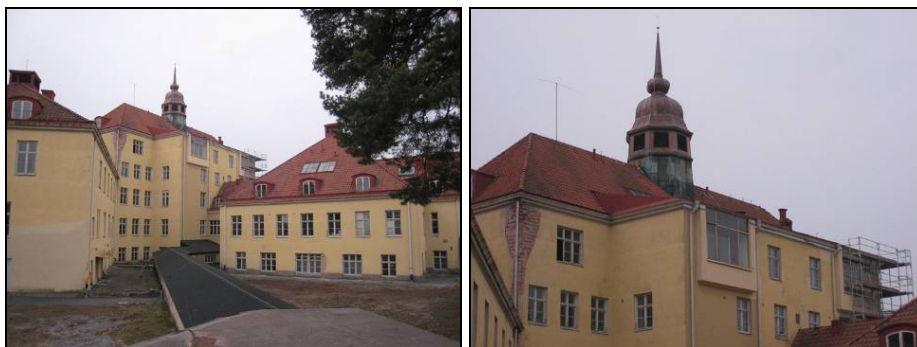
Figur 96. Centralbyggnaden och norra flygeln före renoveringen. Foto: Helén Sjökvist.
