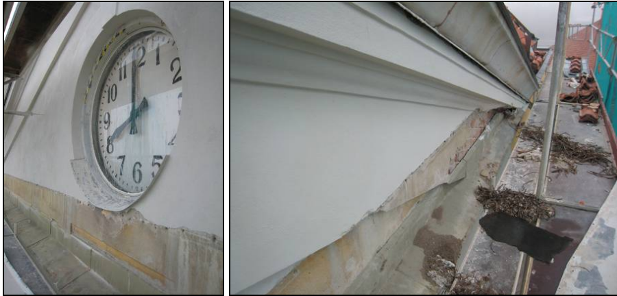
Figur 89. Klockan i huvudfasadens tympanonfält. Strax under kan anas fasadens, troligen ursprungliga gula kulör. Foto: Helén Sjökvist.
