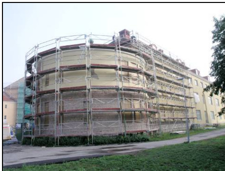
Figur 91. Nedbilning av puts påbörjad på östra flygeln. Foto: Helén Sjökvist.
