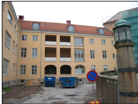
Figur 74. Omputsade fasader. Foto: Helén Sjökvist.
