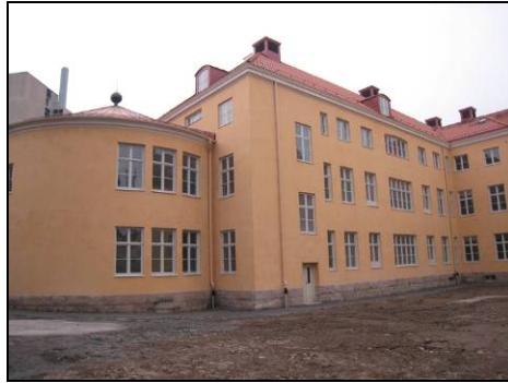
Figur 95. Östra flygeln efter renovering jämför med bild ovan. Foto: Helén Sjökvist.
