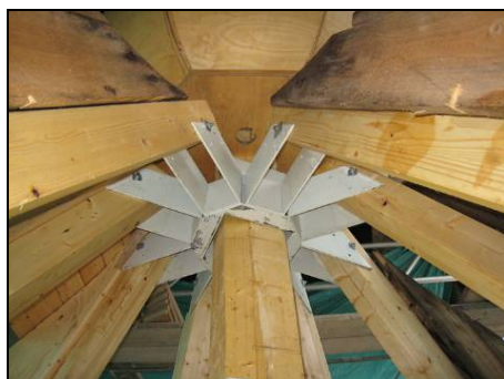
Figur 81. Tornets undertakspanel var svårt rötskadad och byttes. Foto: Helén Sjökvist.
