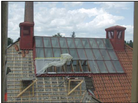
Figur 110. Takfönster med gjutjärnsbågar på byggnad 75. Foto: Helén Sjökvist.
