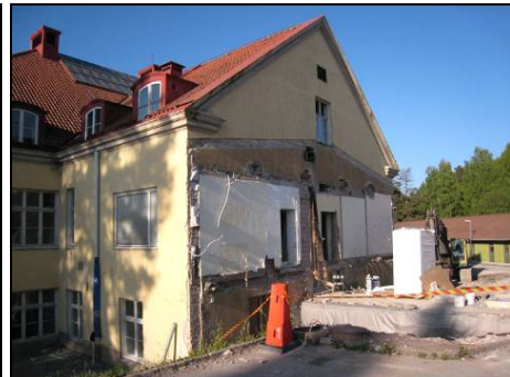
Figur 106. Fasad 3c med omfattande putsbortfall vid stuprör före åtgärder. Foto: Helén Sjökvist.
