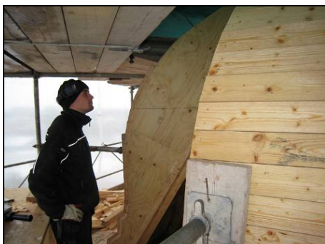
Figur 81. Tornets undertakspanel var svårt rötskadad och byttes. Foto: Helén Sjökvist.
