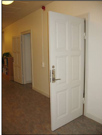
Figur 39. Ny spegelindelad dörr med nytt dörrtrycke. Foto: Helén Sjökvist. Figur 40. Dörr med råglasruta efter renoveringen. Foto: Helén Sjökvist.
