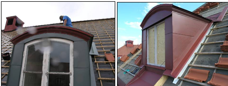
Figur 69. Omtäckning av takkupa med återanvänd profilerad list. Foto: Helén Sjökvist.
