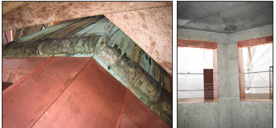
Figur 87. Vissa delar av den äldre kopparplåten kunde bevaras. Foto: Helén Sjökvist.
