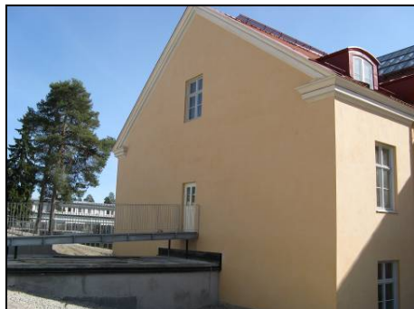
Figur 108. Tillbyggnaden är riven och fasaden på bus 75 är åter putsad. Foto: Helén Sjökvist.
