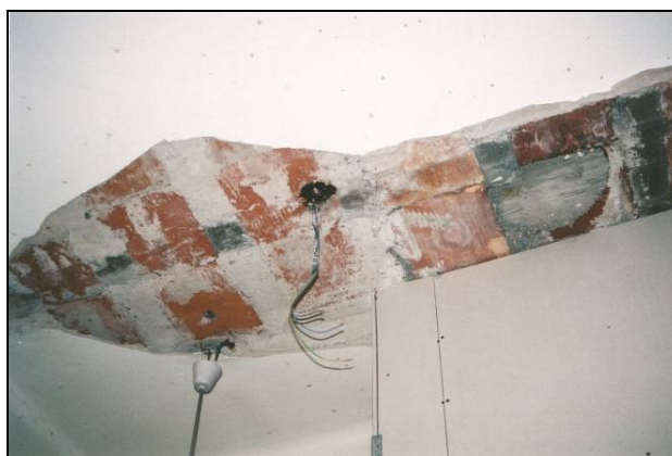
Figur 9. Bjälklag med håltegelutfyllning. Foto: Helén Sjökvist.
