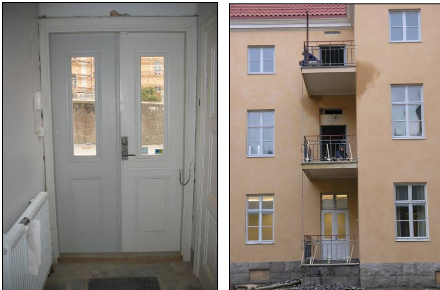
Figur 56. Entré till västra flygelns rundel ifrån sydöst. Dörren har vänts från inåtgående till utåtgående för att klara utrymningskraven. Foto: Helén Sjökvist.
