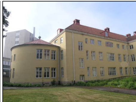
Figur 93. Ventilationshuvarna visade sig då de täcktes av vara murade med lättbetongsten. Foto: Helén Sjökvist.
