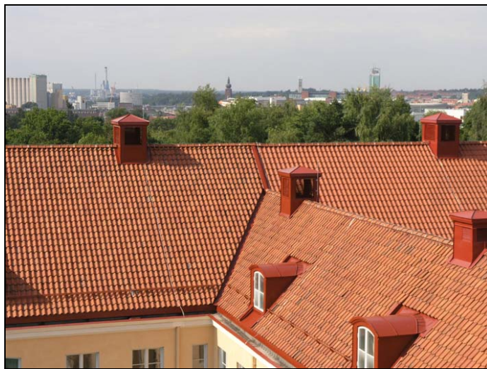
Figur 76. Taken är omtäckta och plåten målad. Foto: Helén Sjökvist.
