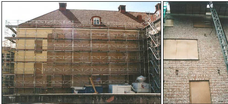
Figur 51. Nedbilning av puts pågår på västra flygeln. Foto: Helén Sjökvist.
