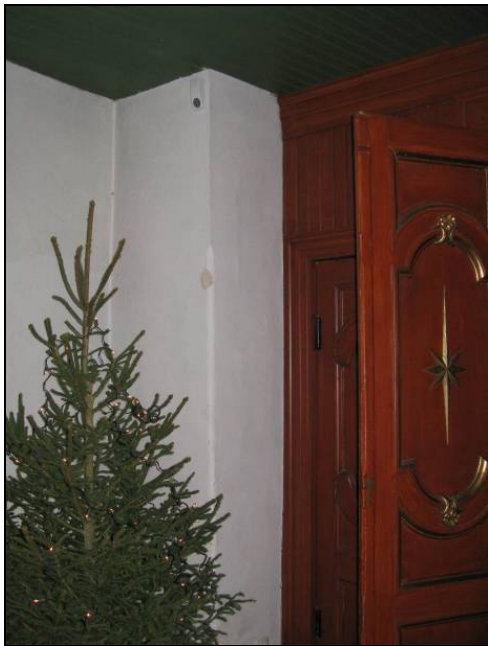
Figur 12. Rörelsedetektor monterad i vapenhusets nordöstra hörn. Foto: Helén Sjökvist.
