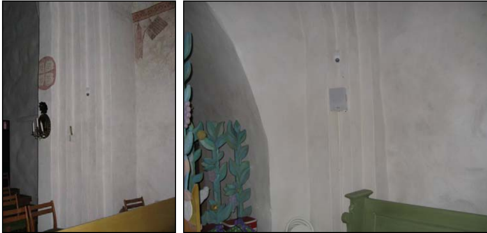
Figur 18. Rörelsedetektor placerad på en av pelarna på norra sidan. Foto: Helén Sjökvist.
