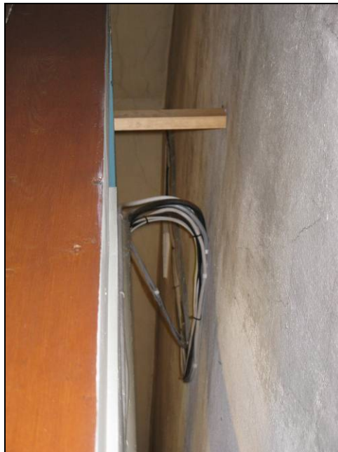
Figur 6. Befintliga elkablar som dragits via orgeln till västra väggen. Foto: Helén Sjökvist.
