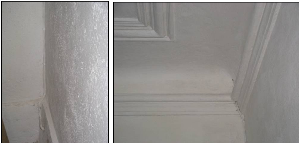
Figur 22. Indragning av kabel till gravkorets nordvästra hörn. Foto: Helén Sjökvist.
