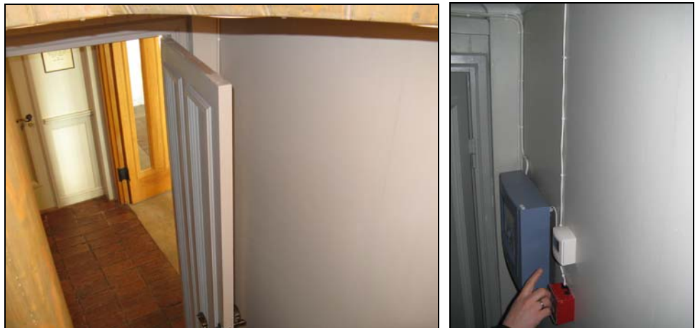
Figur 26. Centralen för brandlarmet kom att placeras bakom dörren till läktartrappan.
