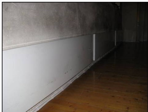
Figur 8. Befintlig dragning av elkablar utmed golvet vid långhusets södra vägg. Till denna har fogats ytterligare en kabel för larmet. Foto: Helén Sjökvist.
