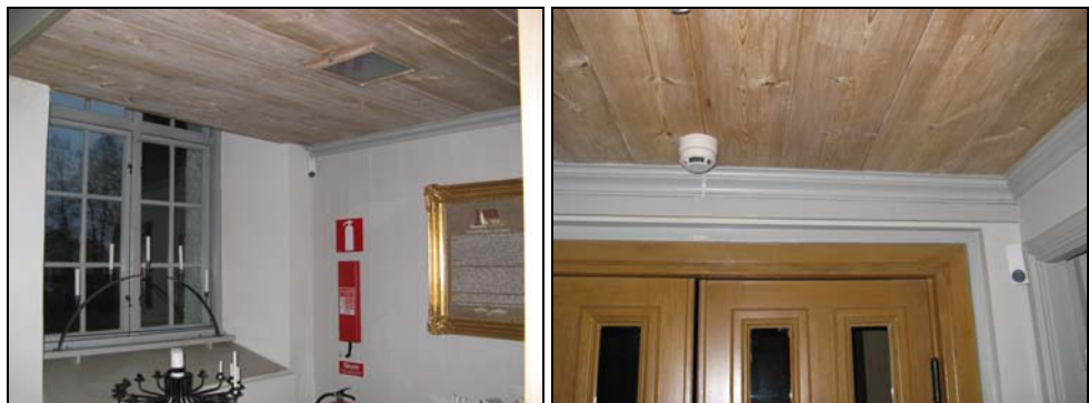
Figur 28. Rörelsedetektor i långhuset. Foto: Helén Sjökvist.
