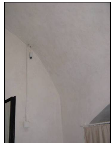
Figur 16. I vapenhuset gjordes en ny håltagning för branddetektorn. Foto: Helén Sjökvist.
