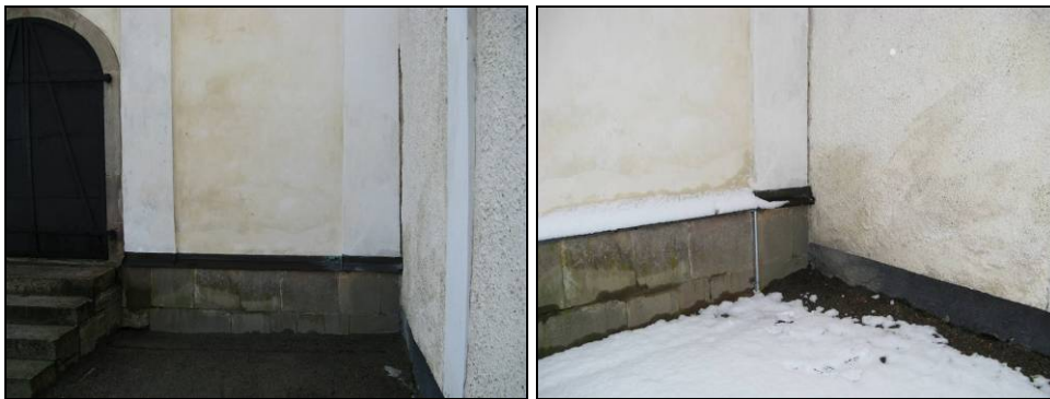
Figur 20. Gravkoret före indragning av kabel till brandlarm. Foto: Helén Sjökvist.
