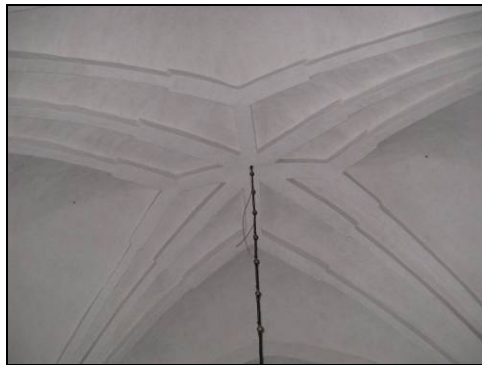
Figur 14. Kabel dragen till detektor i korvalvet. Foto: Helén Sjökvist.
