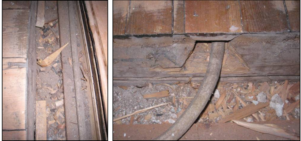
Figur 34. Äldre eldragning i golvet. I fyllningen under golvet finns en hel del putsbitar, möjligen från nedknackningen av den medeltida putsen. Foto: Helén Sjökvist.
