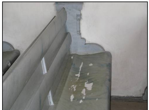
Figur 28 och 29. Spacklingen av bänkarna är utförd. Man anar också den kraftiga gulningen av bänkarnas måleri. Foto: Helén Sjökvist.
