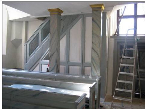
Figur 32. Målning av de nya skåpen under läktartrapporna pågår. Foto: Helén Sjökvist.
