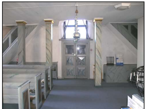
Figur 31. Långhusets västra parti före de nya förvaringsskåpens tillkomst under läktartrapporna. Foto: Helén Sjökvist.
