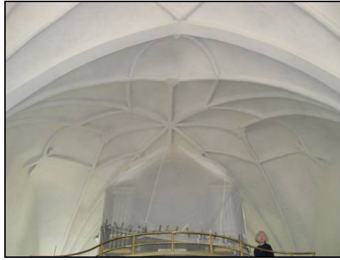
Figur 25. Rengörningsarbetet avslutat. Foto: Helén Sjökvist.
