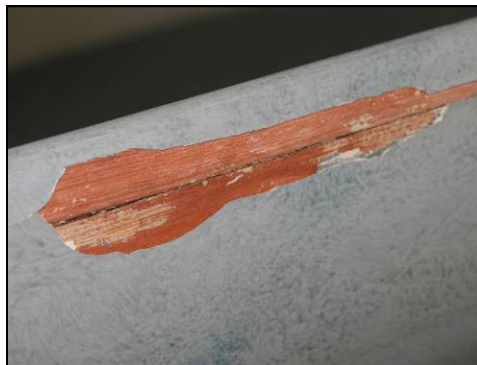
Figur 26 och 27. Skador i bänkarnas bemålning. Foto: Helén Sjökvist.
