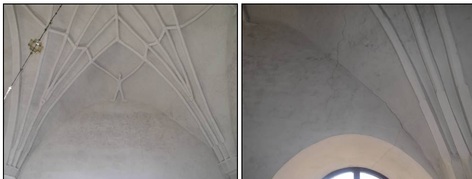
Figur 7. Östra valvet mot norr före rengöring. Foto: Helén Sjökvist.
