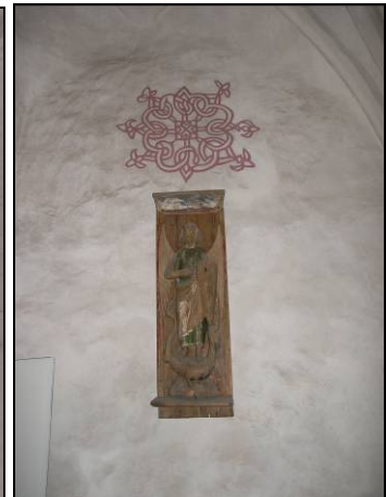
Figur 15. Nälsprickor i putsen på en av "gubbarna". Västra valvets norra sida.
