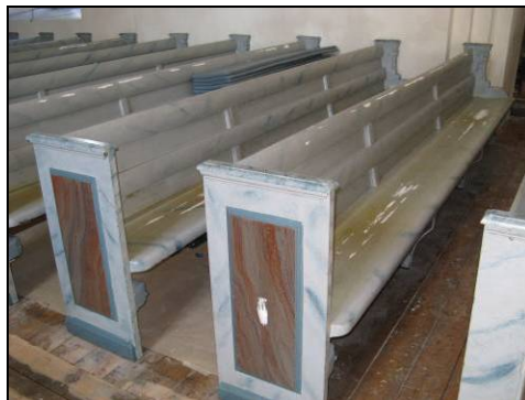
Figur 28 och 29. Spacklingen av bänkarna är utförd. Man anar också den kraftiga gulningen av bänkarnas måleri. Foto: Helén Sjökvist.
