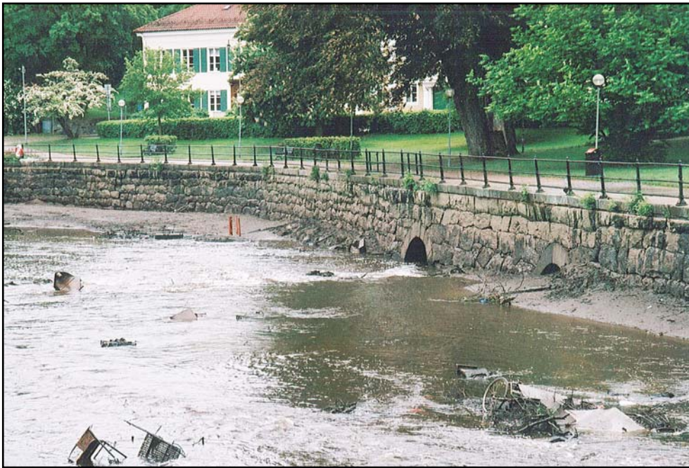
Figur 7. Intaget respektive utflödet av vatten till kvarndriften skedde via de två öppningarna med valvöverbyggnad på respektive sida av dammbyggnaden. Foto från norr. (Foto U. Alström.)
