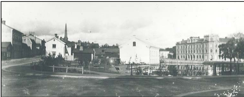
Figur 3. Centralt i bild är Wickholms kvarn. Bebyggelsen i Stadsparken är ännu inte riven. Till höger i bild syns den nya turbinbron med damluckorna. Bilden tagen från söder, troligen 1891 (VLM:s arkiv).
