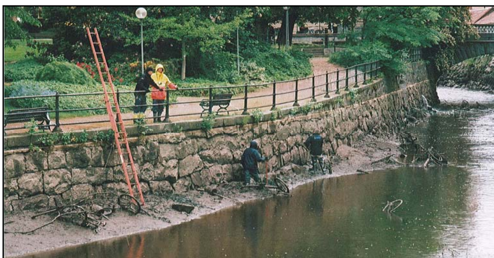
Figur 4. Undersökning av Svartåns västra stenskoning vid stadsparken. (Foto U. Alström.)
