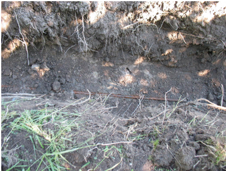
Figur 3. I botten på schakt A, på cirka 1,2–1,6 meters djup, återfanns den äldre vattenledningen. Foto Anna-Lena Hallgren.
