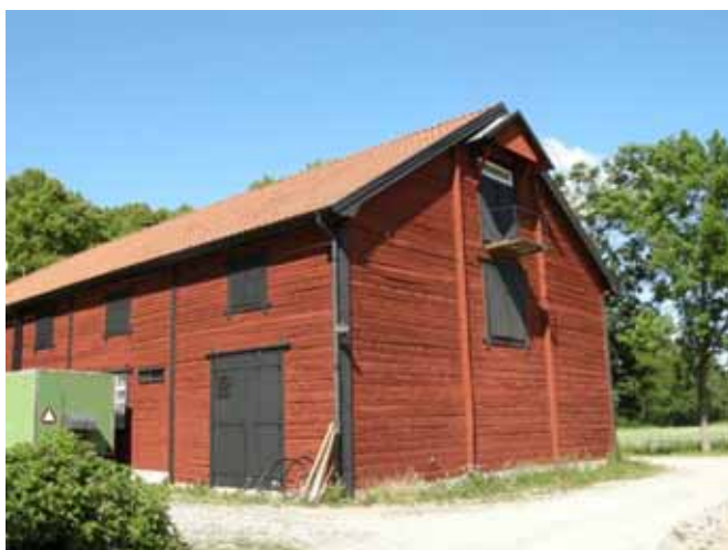
Figur 58. Byggnad 7 från sydöst.
