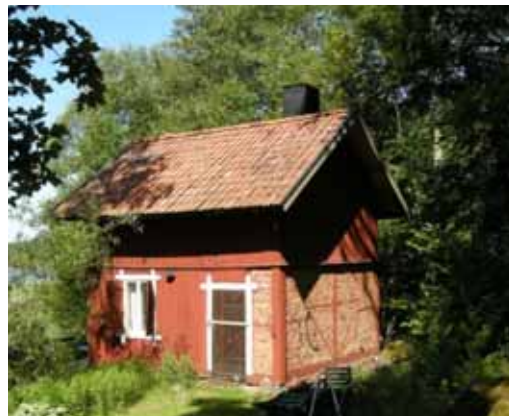
Figur 13. Tvättstuga från norr.
