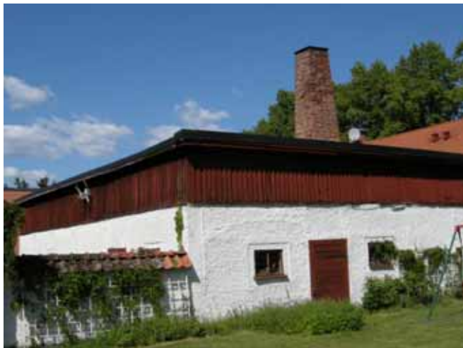
Figur 41. Byggnad 2 från söder.
