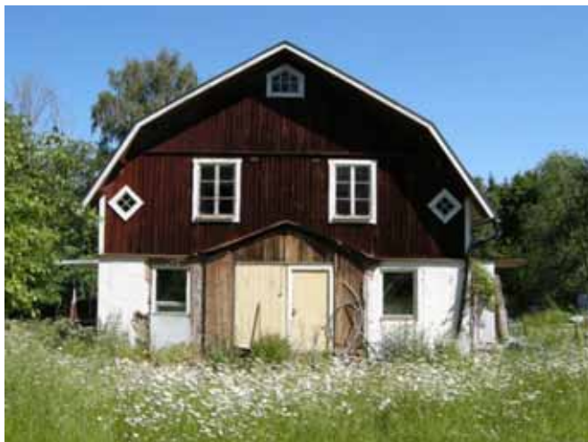
Figur 18. Huset från söder med rester av äldre förstuga.
