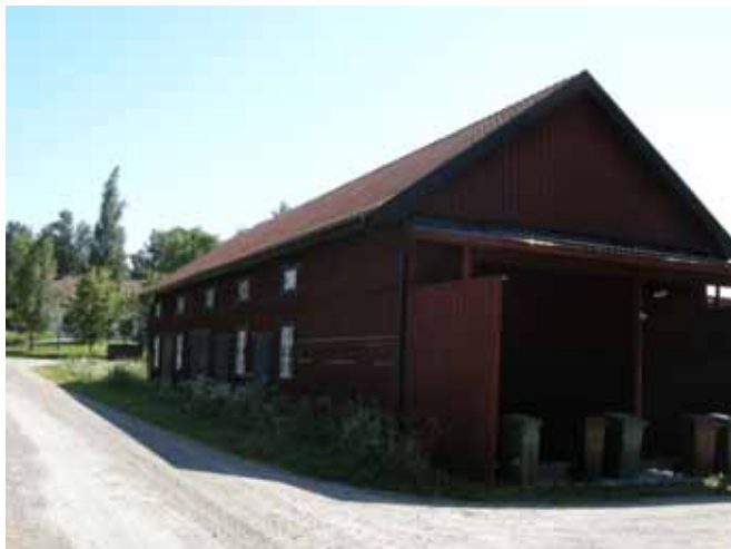
Figur 59. Byggnad 7 från nordväst.
