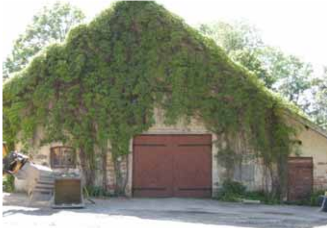
Figur 51. Byggnad 6 från öster.
