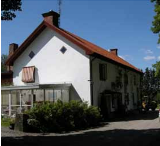
Figur 38. Byggnad 1 från söder med den inglasade uteplatsen.
