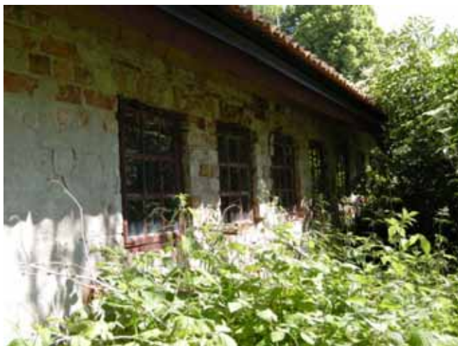
Figur 49. Byggnad 4 från öster med tillbyggnaden.
