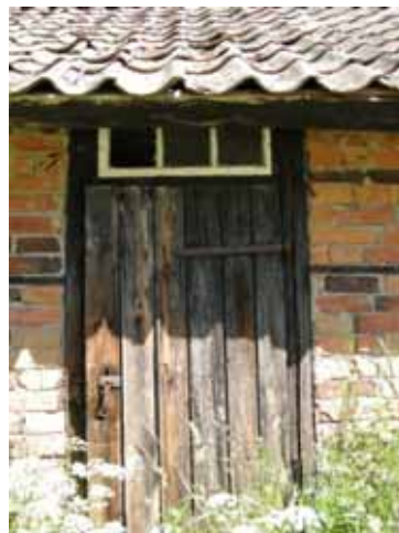
Figur 27. Dörr med ovanluft.
