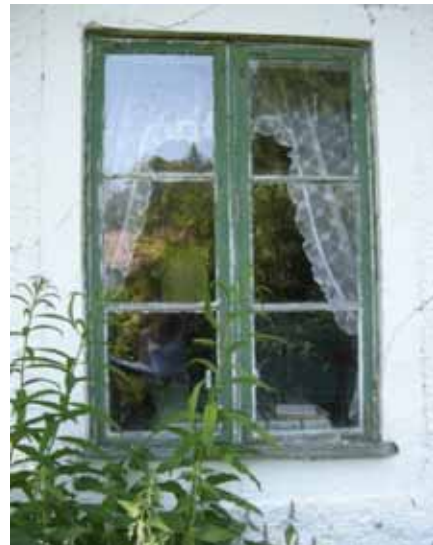
Figur 35. Fönster på södra gaveln.
