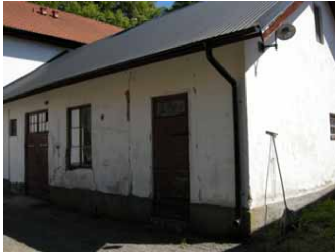
Figur 45. Byggnad 3 från nordost.
