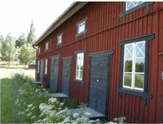
Figur 61. Byggnad 8 från öster.
