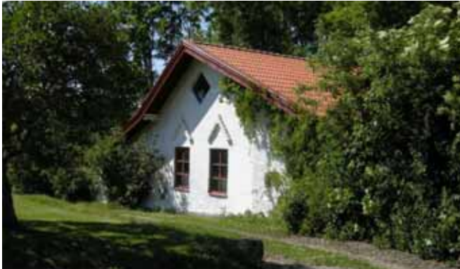
Figur 46. Byggnad 4 från söder.
