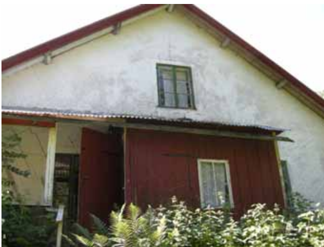
Figur 31. Förstuga på byggnadens norra gavel.
