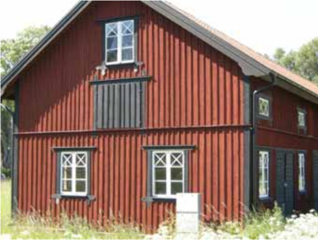
Figur 60. Byggnad 8 från söder.
