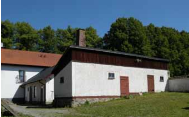
Figur 42. Byggnad 2 från öster.
