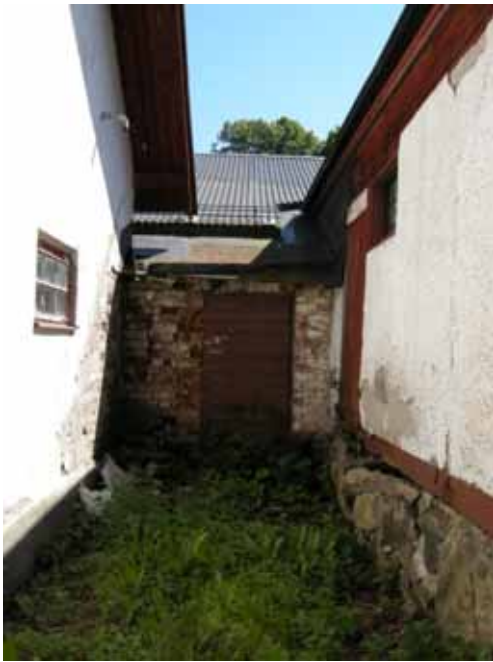
Figur 43. Byggnad 2 från norr sammanbyggt med hus nr 3.
