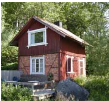
Figur 12. Tvättstuga från söder.
