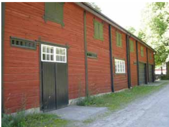
Figur 56. Byggnad 7 från sydväst.
