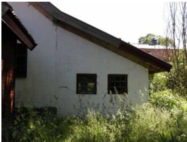
Figur 48. Byggnad 4 från norr.
