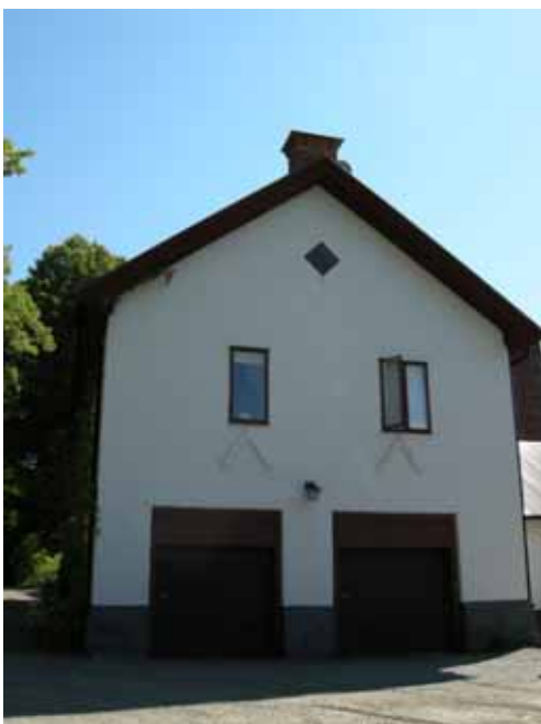
Figur 40. Byggnad 1 från norr.
