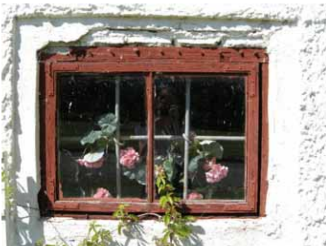
Figur 44. Detalj fönster på byggnad 2.
