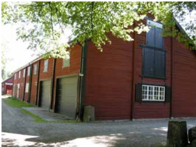
Figur 55. Byggnad 7 från nordväst.
