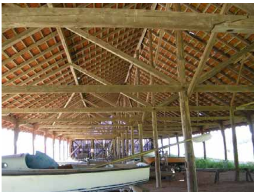
Figur 11. Interiör med regelverk och takkonstruktion.
