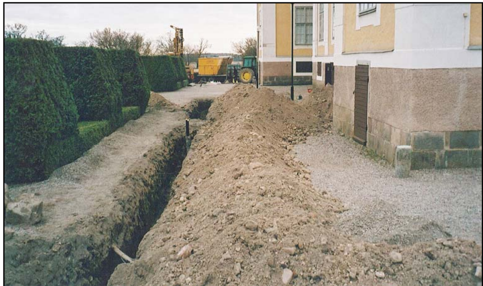
Figur 9. Bergvärmeschaktet öster om slottet fotograferat från norr. Schaktet sträckte sig så småningom ända fram till bergvärmeborren som sticker upp ovanför grönskan i fonden. (Foto U. Alström.)
