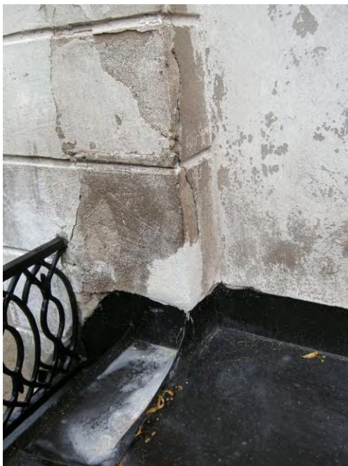
Figur 18. Ilagning av puts-skador.
