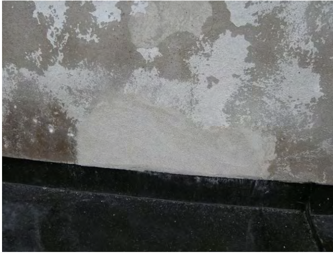
Figur 17. Ilagning av puts-skador.
