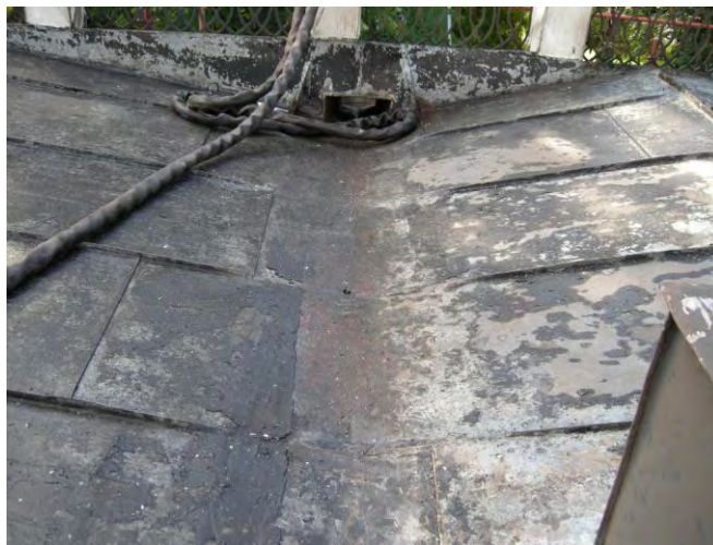
Figur 8. Östra rännalens med rester av hagmanit innan kolsyreblästringen.
