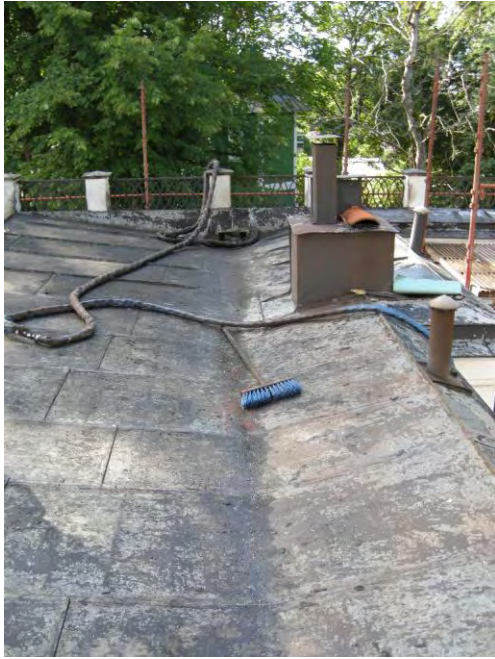
Figur 10. Östra rännalden efter kolsyreblästringen, lägg märke till de nedslagna falsarna.
