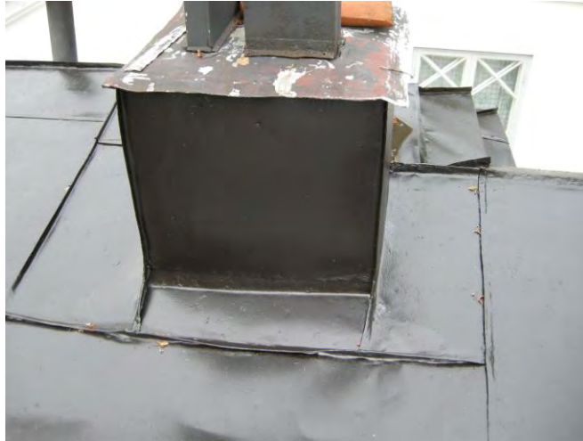
Figur 13. Plåt bytt vid skorstenen på östra sidan om atriets.
