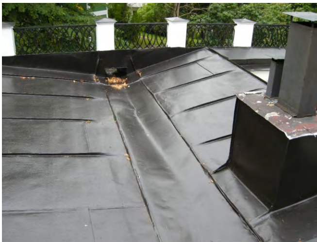
Figur 11. Plåt bytt i takets östra rännald.
