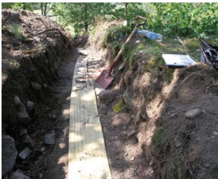
Figur 2. Det gamla kabelschaktet över åsen återöppnades. I den södra schaktväggen (till vänster i bild) berörde det nya schaktet ställvis orörd mark. Fotograferat från öster av Anna-Lena Hallgren.
