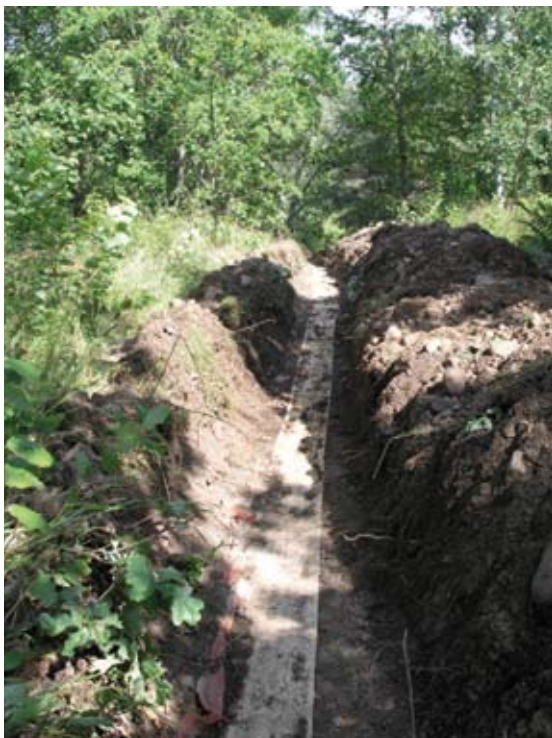
Figur 8. Det gamla kabelschaktet öppnat på åsens västra sida, ner mot vägen mellan Kolbäck och Strömsholm. Det breda plastbandet markerar platsen för den elledning som nu skulle bytas ut. Norr om denna, till vänster i bild, syns delar ett brandgult plastband som markerar en nedgrävd teleledning. Fotograferat från väster av Anna-Lena Hallgren.
